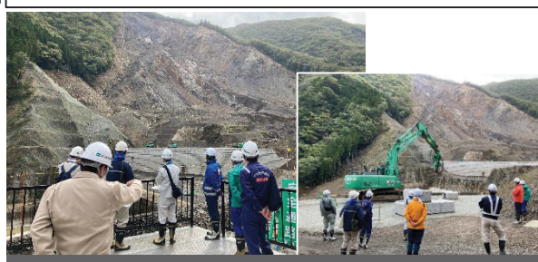
赤谷地区では無人化施工による土砂の敷き均しの実演、自動化施工によるブロック据え付け技術の解説をしました。
