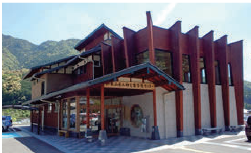
写真 2.1.1 大規模土砂災害対策技術センター（和歌山県土砂災害啓発センター内に入所）
