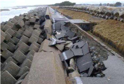
写真-2.2.5.1 海岸堤防の被災（下新川海岸）
