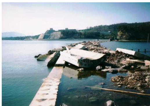
写真-2.2.2.2 熊本県手場海岸の堤防被災
