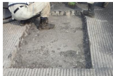
写真-5 緊急補修時の施工面の例
