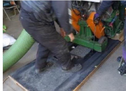
写真-4 基層上面に対するショットブラスト処理
