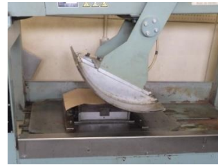
写真-3 ローラコンパクタによる転圧
