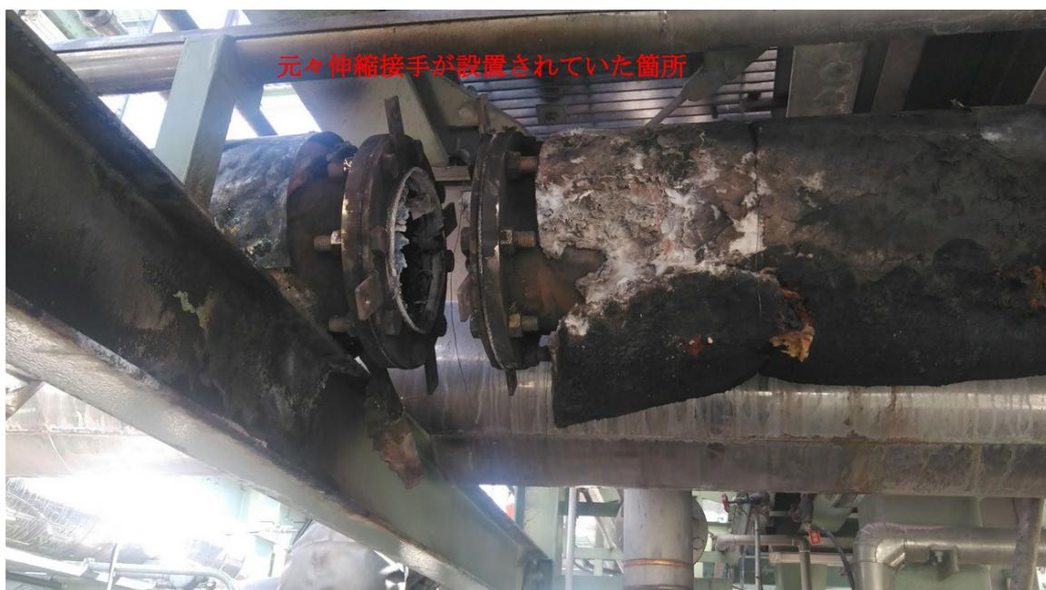
図資 3-4 循環ブロワ吐出配管の状況
