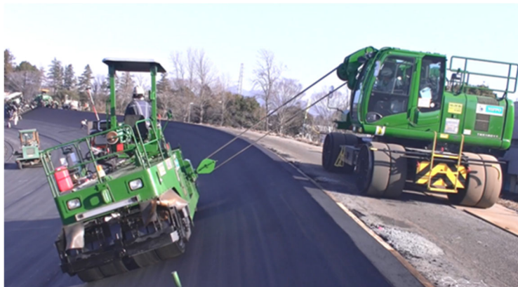
図 4-9-3 試験走路バンク部の舗装改修
