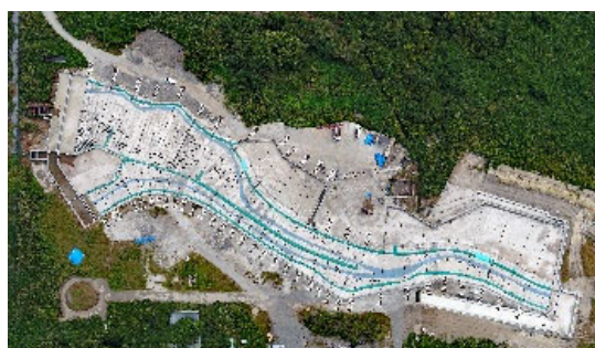
河川模型実験施設
