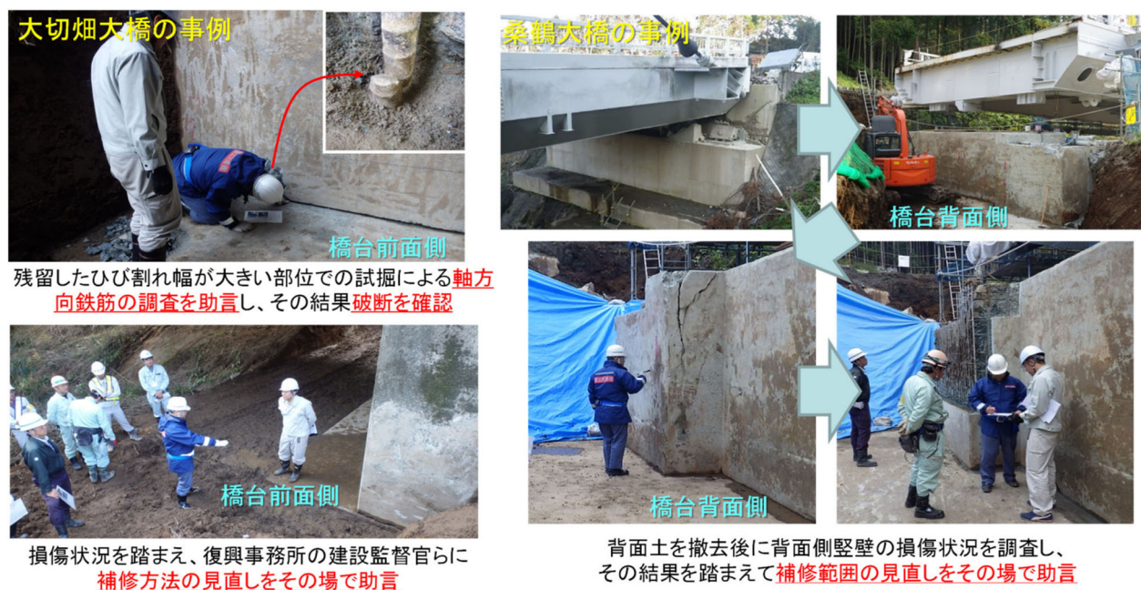
図 3-9-2 道路橋の復旧現場での復旧研の技術支援状況例
