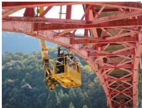
図3-13-2 現地調査参加の様子
