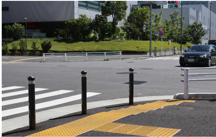
図 4-9-1 交差点でのボラードの設置事例
