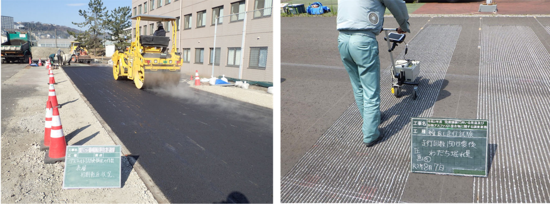
図 4-8-1 空港舗装試験フィールド
