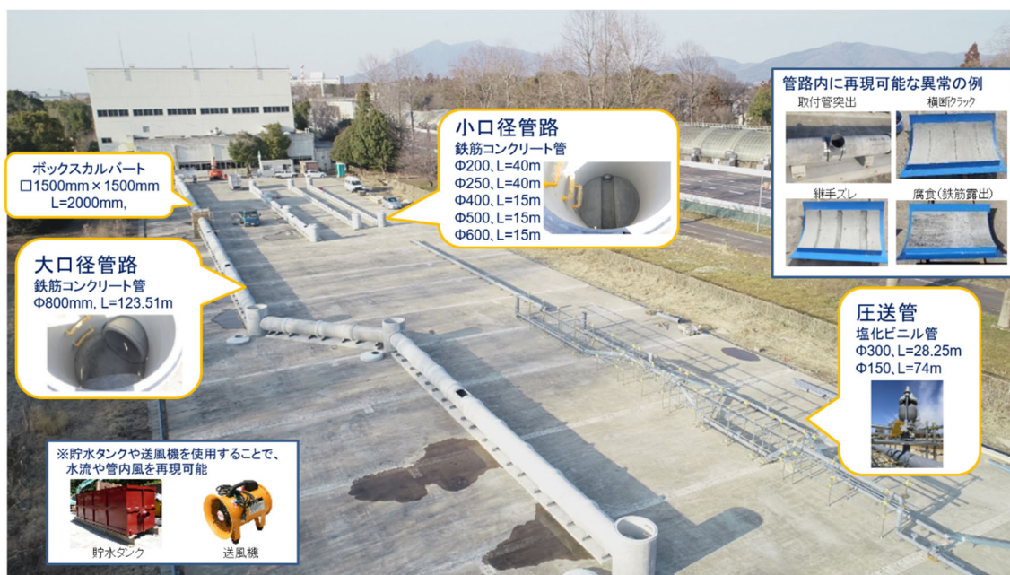
図 4-4-4 下水道管路模擬施設
