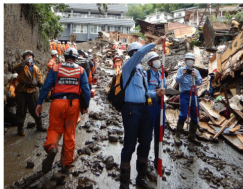
図 4-2-1 令和 3 年 7 月静岡県熱海市で発生した土石流災害における現地調査状況
