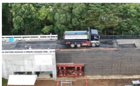
道路基盤構造実験施設
