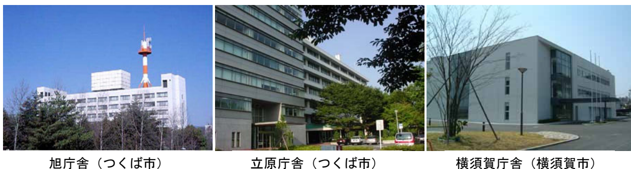
図 3-20-1 各庁舎の外観
