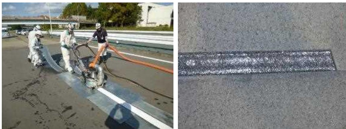
図 3-3 剥離した区画線の再現（左:施工の様子、右:剥離した区画線）
