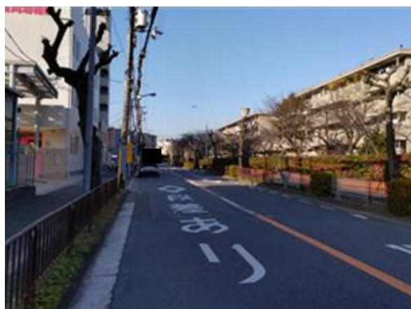
路面表示(第1工区)
