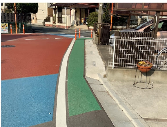
沿道出入り口とのすりつけ
