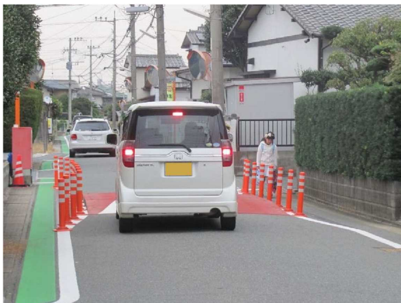
提供:福岡国道事務所
