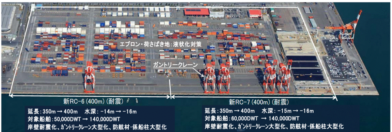
図-6.1.2 RC6-7 ターミナル改良工事
