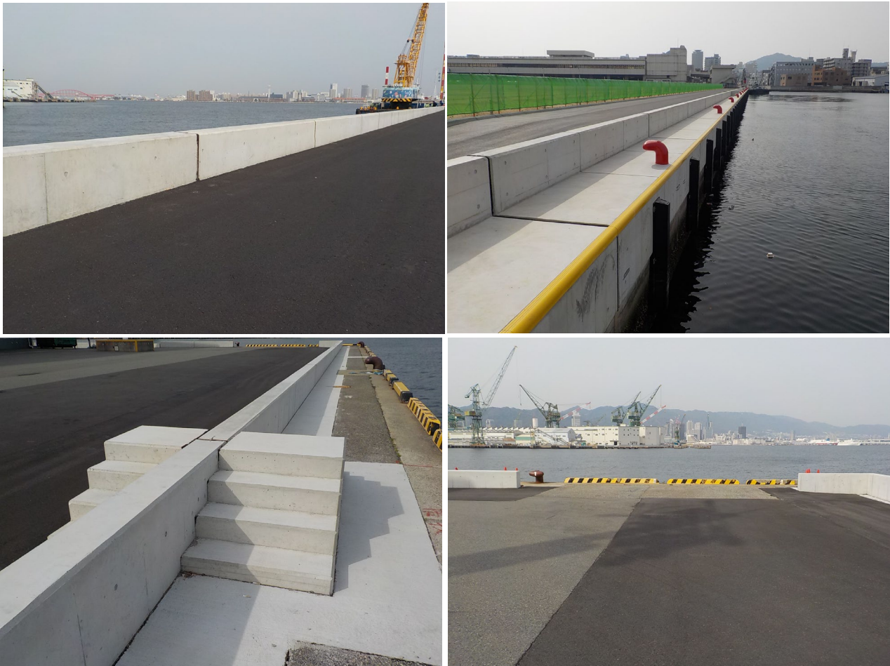
写真-5.2.1 兵庫埠頭での防潮壁設置状況
