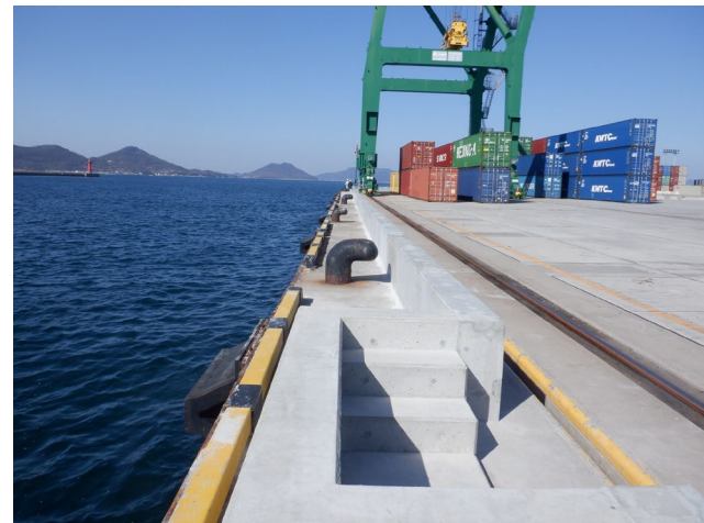
写真-7.1.1 高松港での防潮壁設置状況
