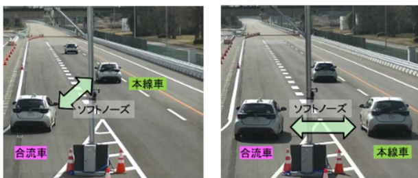
図-4 ソフトノーズ端付近での合流車と本線車の様子 (左：合流支援あり、右：合流支援なし)
