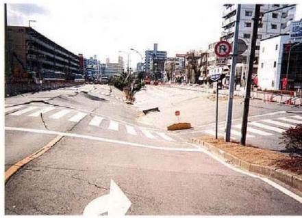
写真 3.1-2 国道28号線路面の陥没状況
