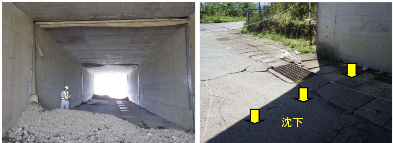
図 4.4 九州道ボックスの被害の状況 (2/2) <sup>28)</sup>
