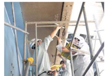
橋梁初級Ⅰ 現地実習
