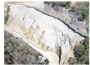
図-1 戸下大橋下側斜面
