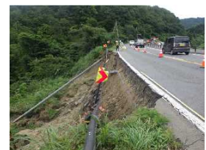
写真-1 長大切土崩壊 写真-2 長大盛土崩壊
