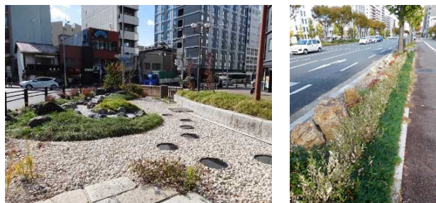
写真-1 雨水貯留浸透機能を付加した植栽帯（雨庭）の事例 （左：京都市四条堀川交差点、右：同 堀川通）
