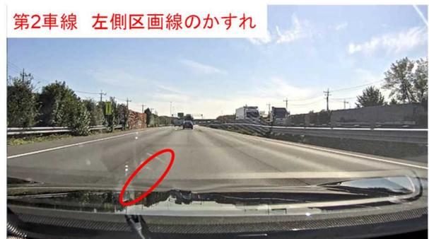
図-5 車載カメラが検知できなかった箇所例
