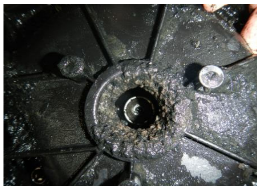
図資 1-45 取水設備 MAP 析出状況（左：脱水ろ液取水ポンプ，右：吐出配管）
