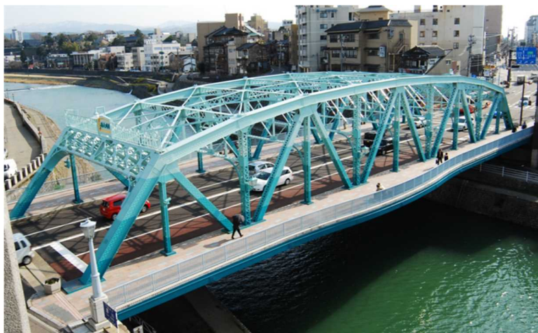
図 参 4-1 国道 157 号犀川大橋
