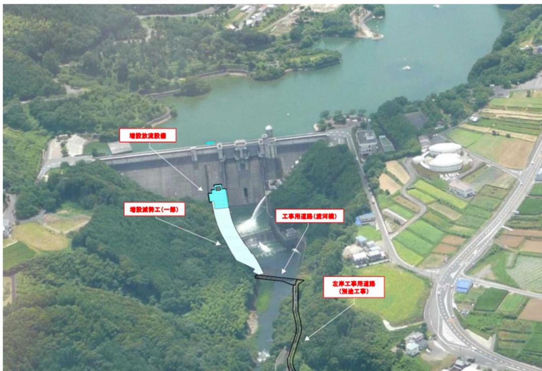
図 参 26-1 野村ダム施設改良工事
