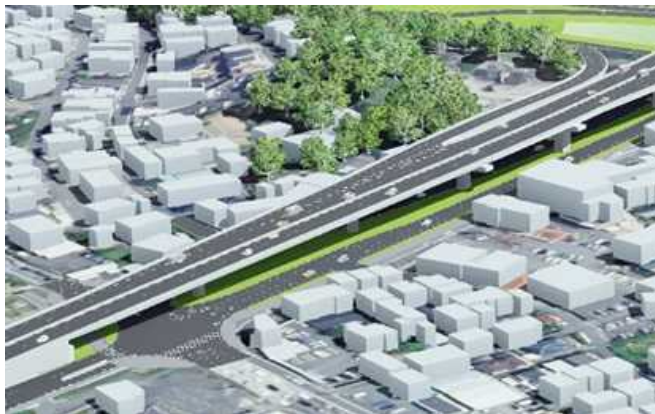
図-3-10 八坂高架橋
