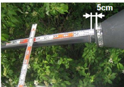
(b) 定着部でのゴムカバーからのずれ
