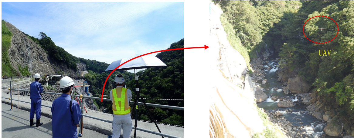
写真-4.10 UAV レーザ計測状況（令和3年9月調査時）
