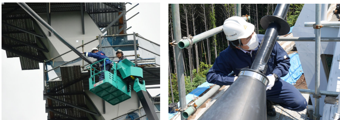
写真-3.3 復旧研若手研究官による斜張橋ケーブルの調査の様子
