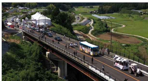
(b)俵山トンネルルート(R1.9 全線開通)
