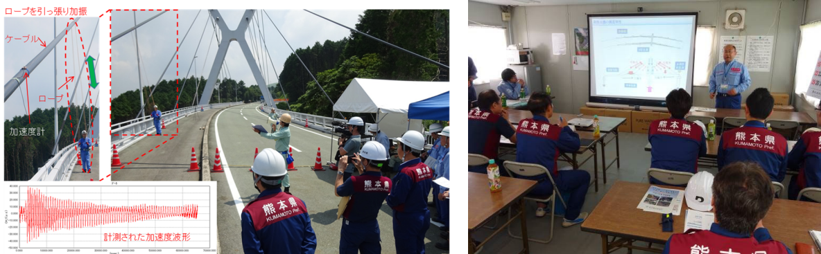
(1) ケーブル張力の確認試験状況
