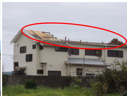
木造小屋組の飛散(令和元年房総半島台風)
