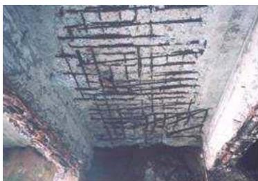
栈橋下面のコンクリート剥離
