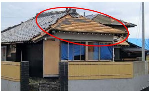
屋根瓦の脱落・飛散(令和元年房総半島台風)
