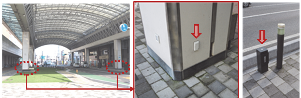
写真-2 コンセントボックスの設置（市道駅前太平線）
