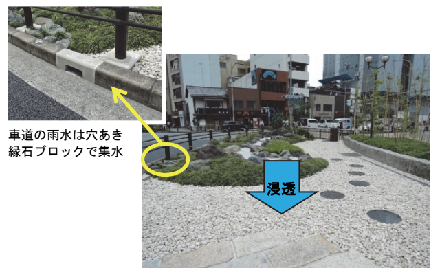
写真-1 四条堀川交差点の事例 (雨水は「洲浜」と呼ばれる碎石の間隙とその上部空間に貯留され、ゆっくり浸透していく)
