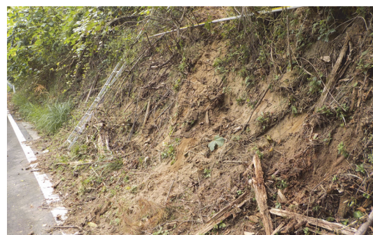
写真-1 イノシシによる植生剥離と基盤流出
