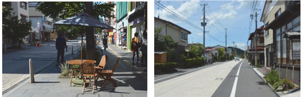
写真-1 歩車道境界の段差解消（左：市道長野中央通り線、右：県道 110 号中尊寺通り）
