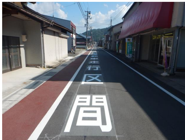
図3-38 路面標示設置後
