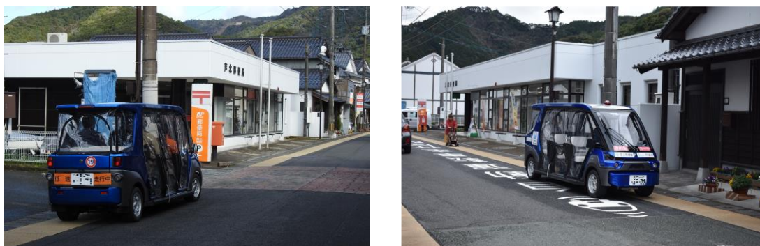
図3-20 路面標示の設置（左：設置前、右：設置後）
