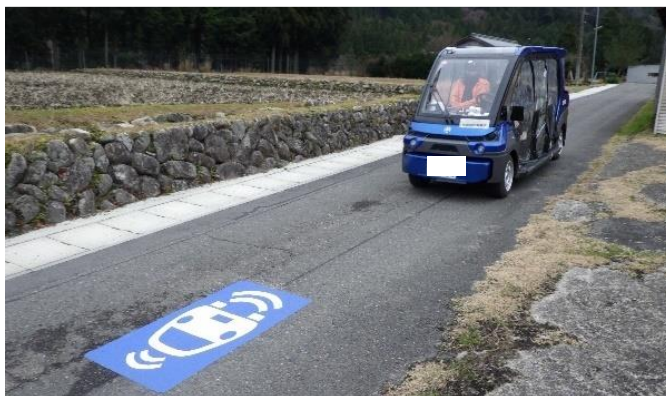
図3-27 路面標示の設置
