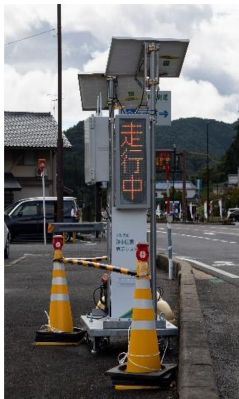
図3-40 接近表示板の設置
