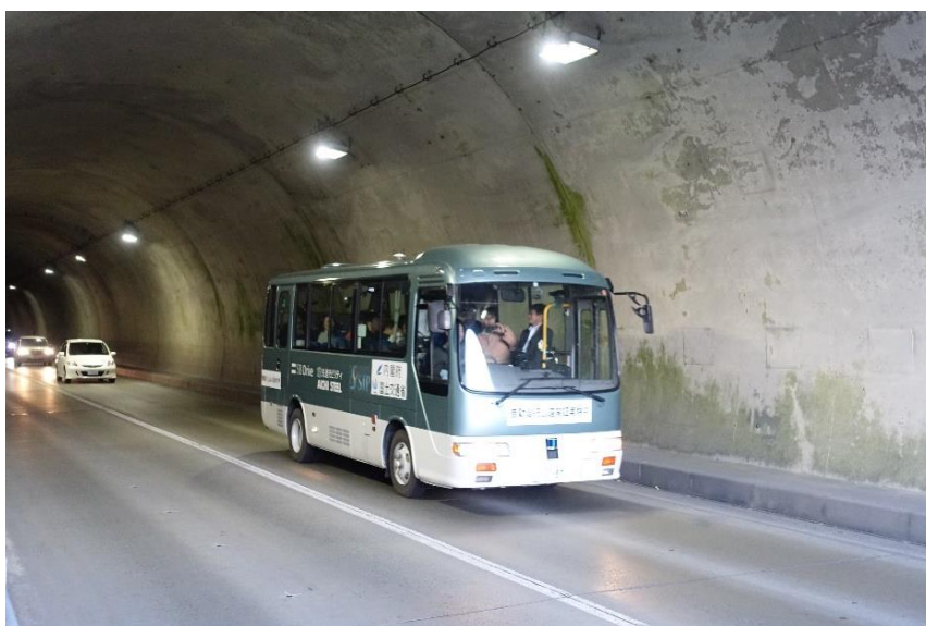
図3-18 トンネル内で自動運転を継続している状況（磁気マーカ方式）
