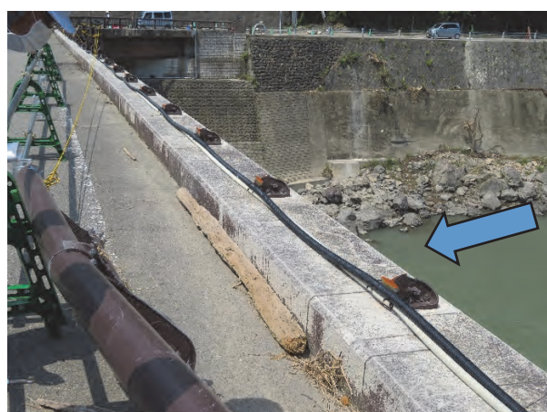
写真-3.1.53 支柱基部で損傷した上流側の防護柵
