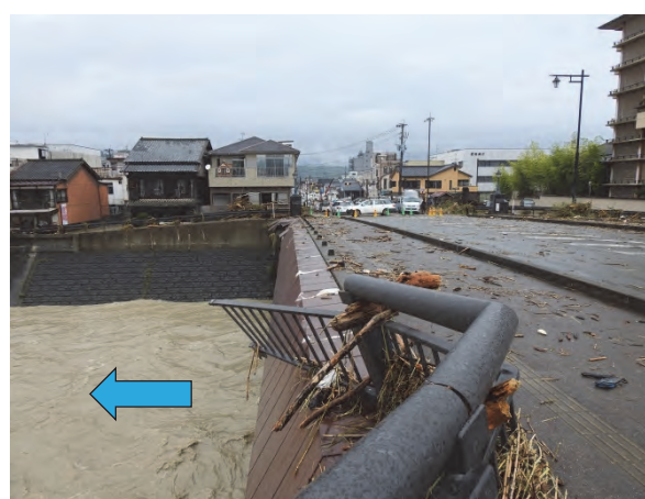
写真-3.1.101 防護柵の損傷（右岸下流側）
