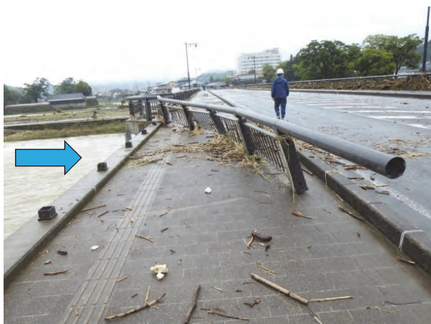
写真-3.1.100 防護柵の損傷 （上写真の丸囲み部）
