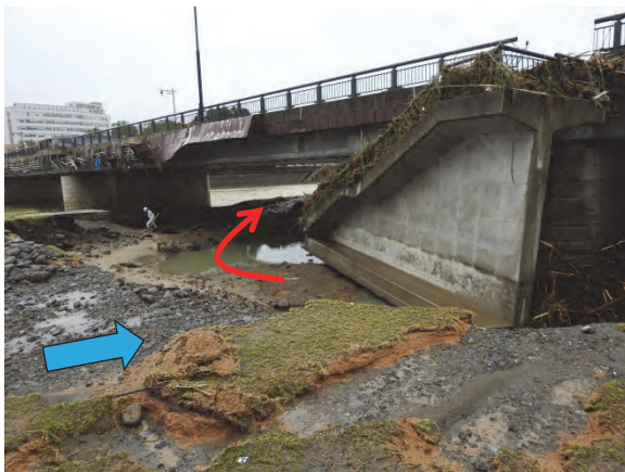
写真-3.1.106 階段部の回転・沈下・傾斜
