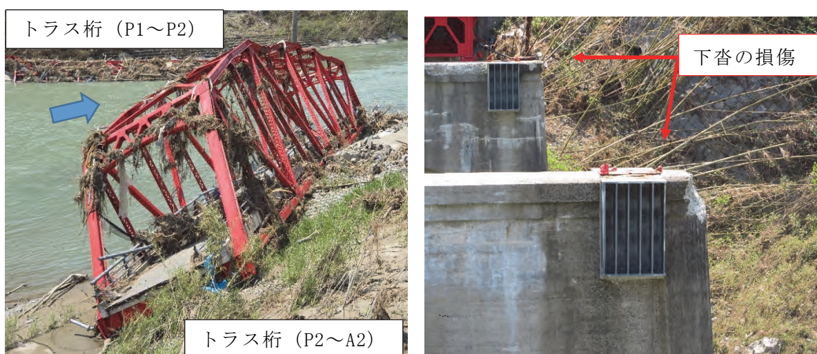
写真-3.1.64 流失したトラス桁及び下沓の損傷状況
