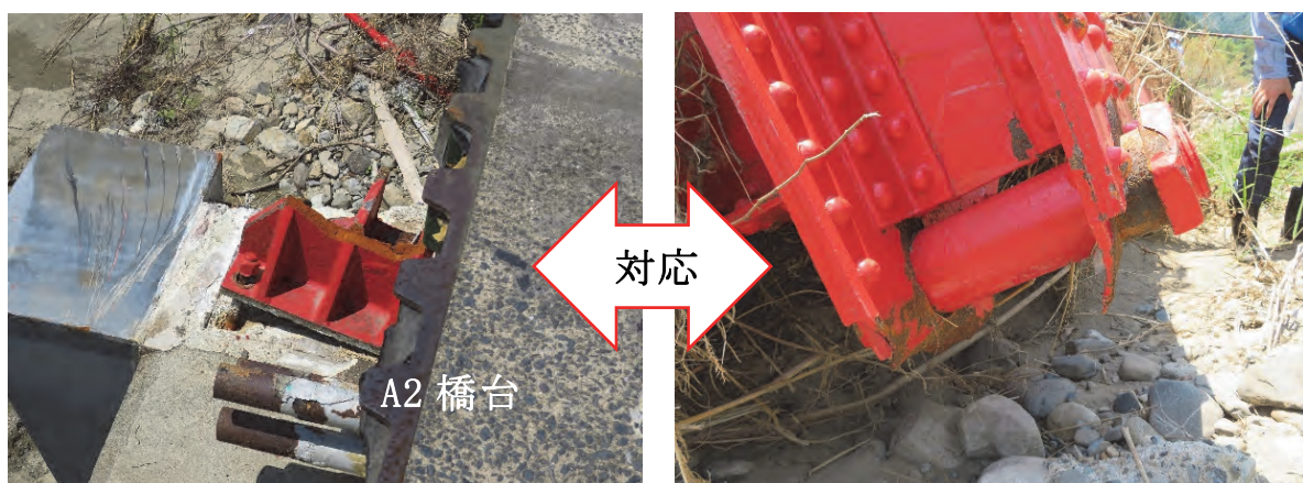
写真-3.1.63 トラス桁 (P2～A2) 下流側ピン支承の下沓の損傷状況
