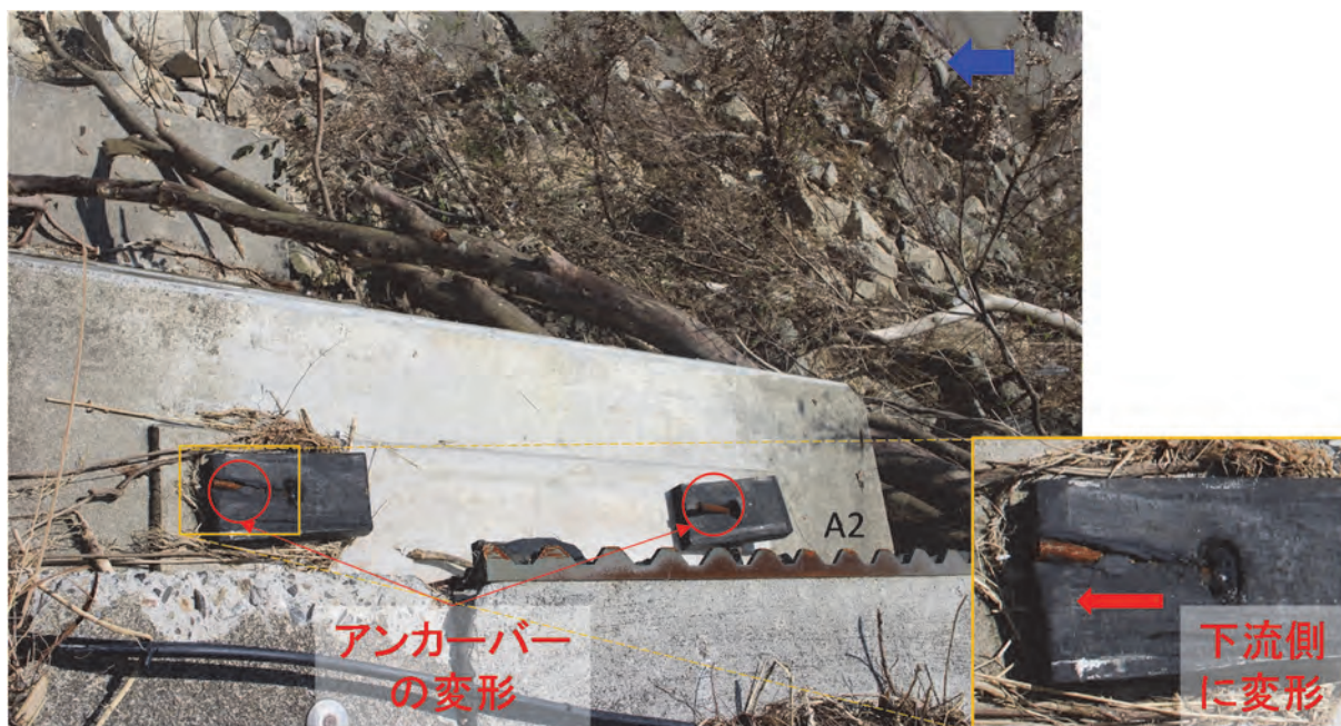
写真-3.1.48 A2 橋台の変状状況（A2 上から撮影）
