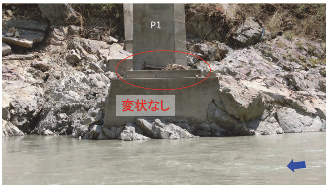
写真-3.1.44 遠望目視による P1 橋脚の状況（A2 側から撮影）
