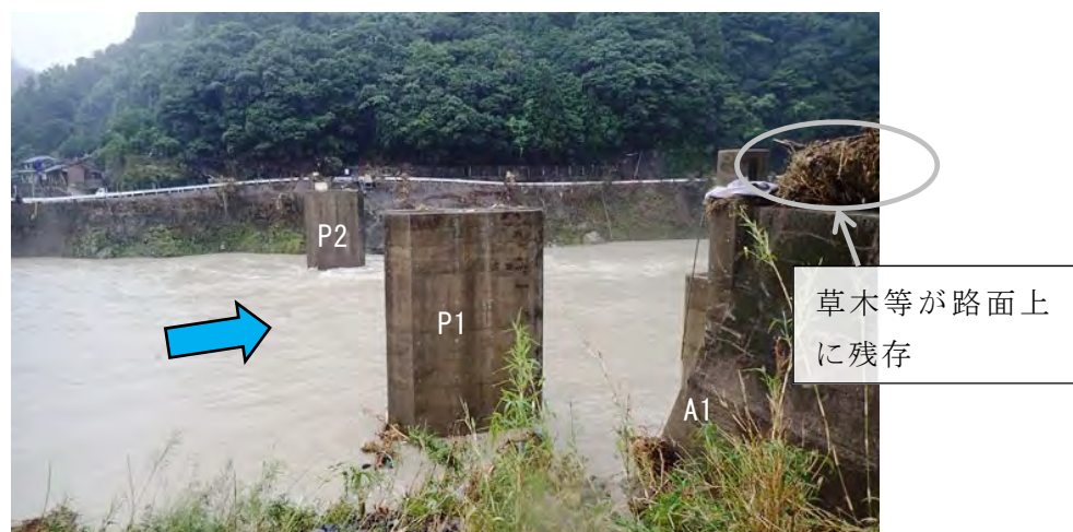
写真-3.1.33 上部構造の流失
