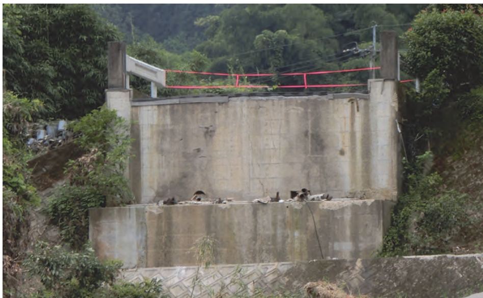
写真-3. 1. 72 橋座部の欠け (A2)
