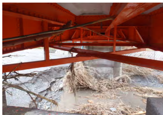
写真-3. 1. 5 被災直後の P3～A2 桁
