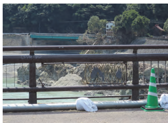
写真-3.1.52 左岸側径間の防護柵飾り枠部流出
