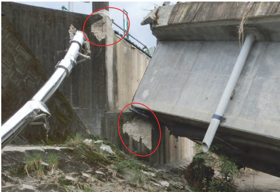
写真-3.1.70 パラペットとたて壁の欠け (A1)
