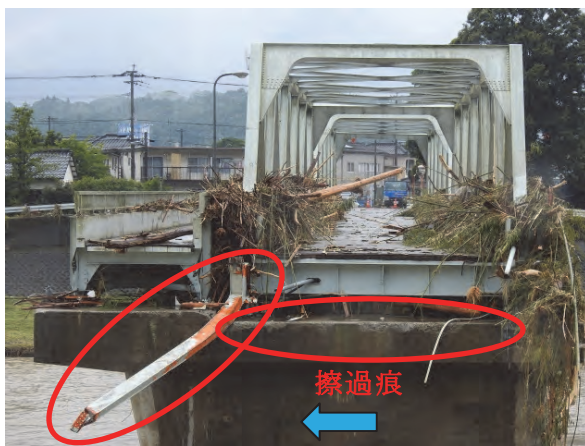
写真-3.1.92 P2 橋脚と上部構造の状態
