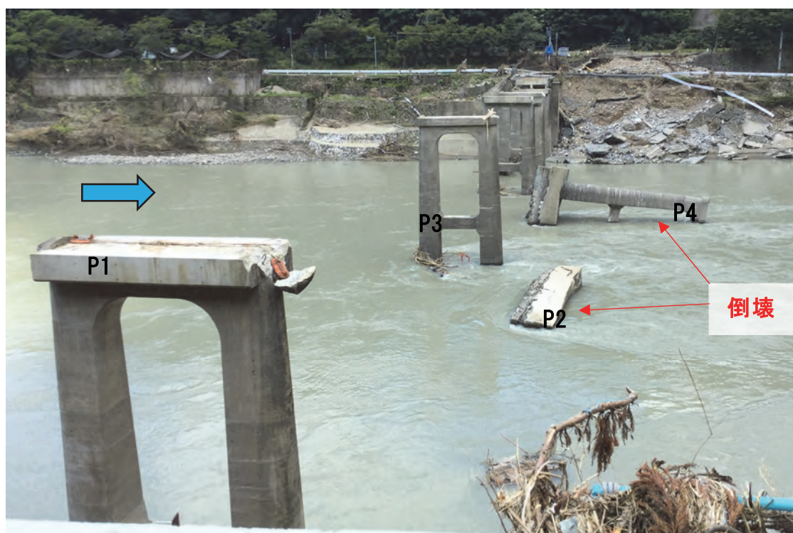
写真-3.1.20 橋脚の倒壊
