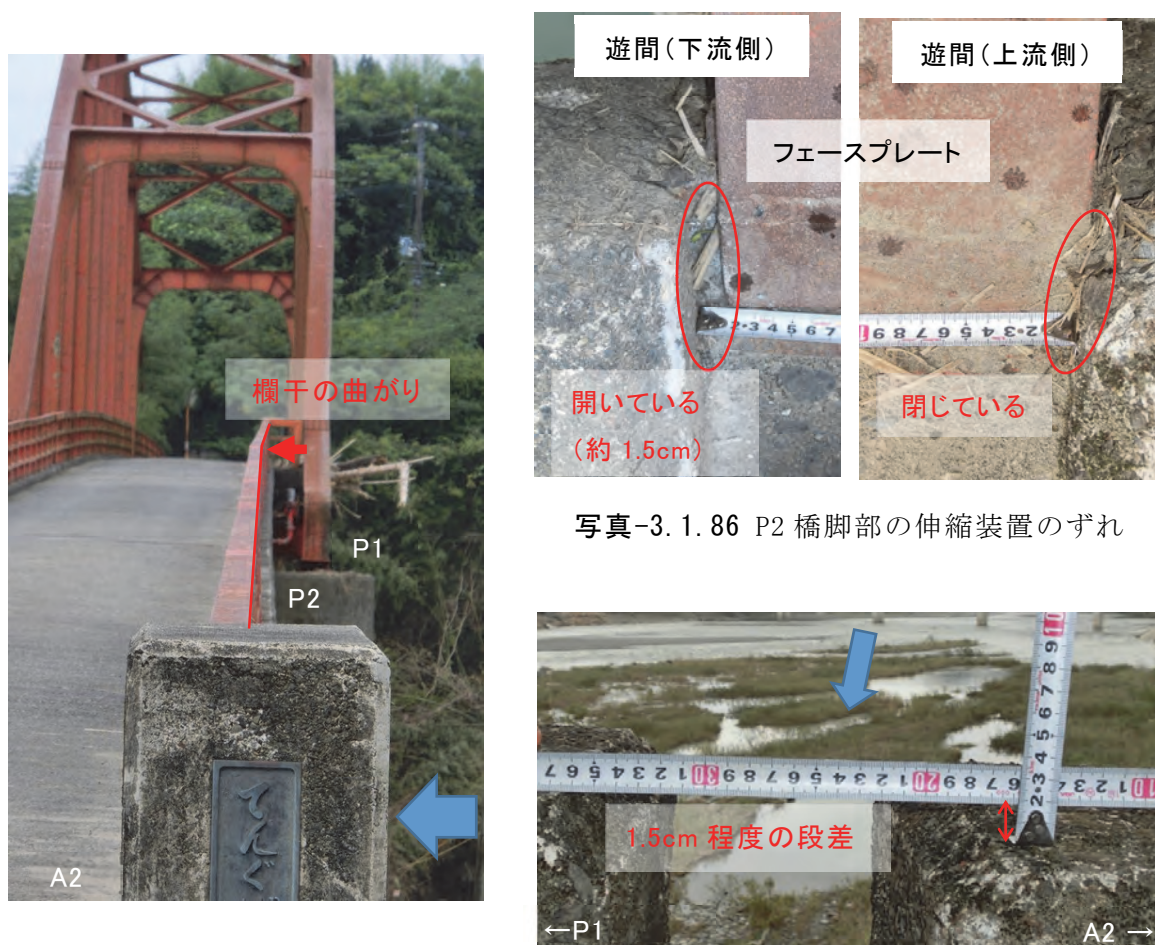
写真-3.1.85 高欄の曲がり (A2 側より)
