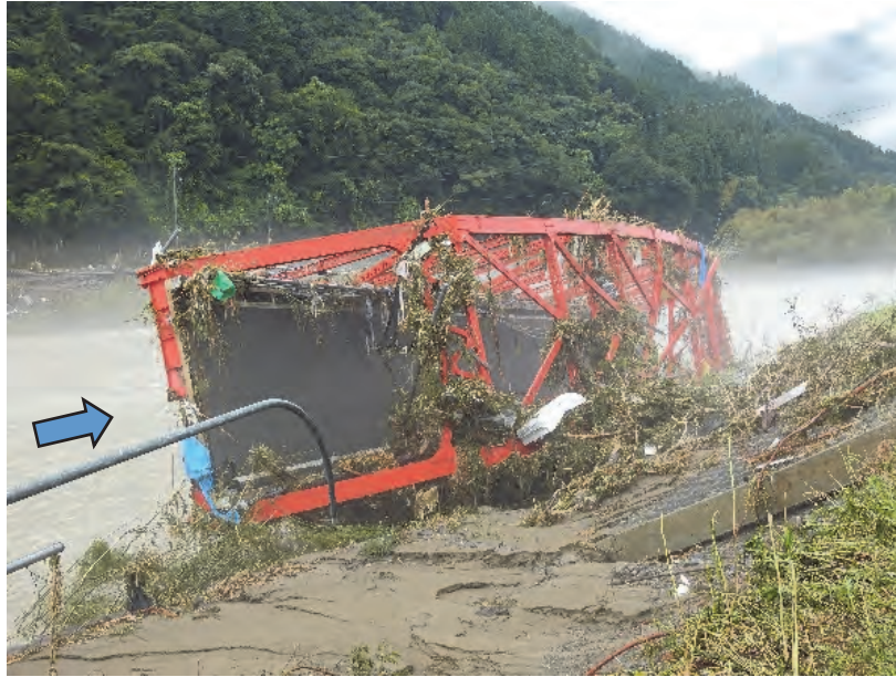
写真-3.1.65 流失した P2～A2 径間のトラス桁（7月7日撮影）
