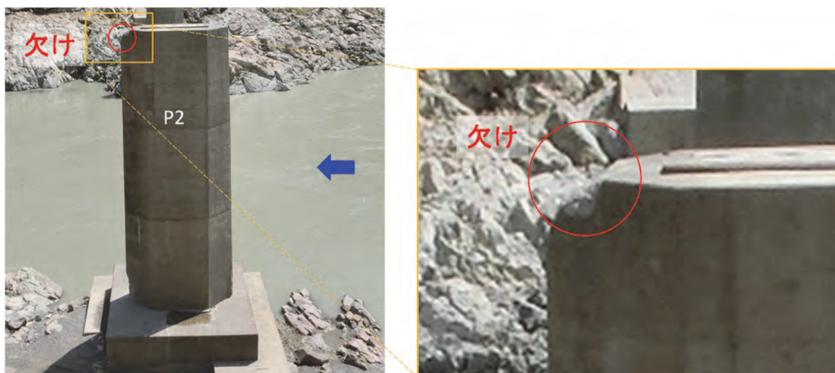
写真-3.1.46 P2 橋脚天端部の欠けの状況（A1 側から撮影）
