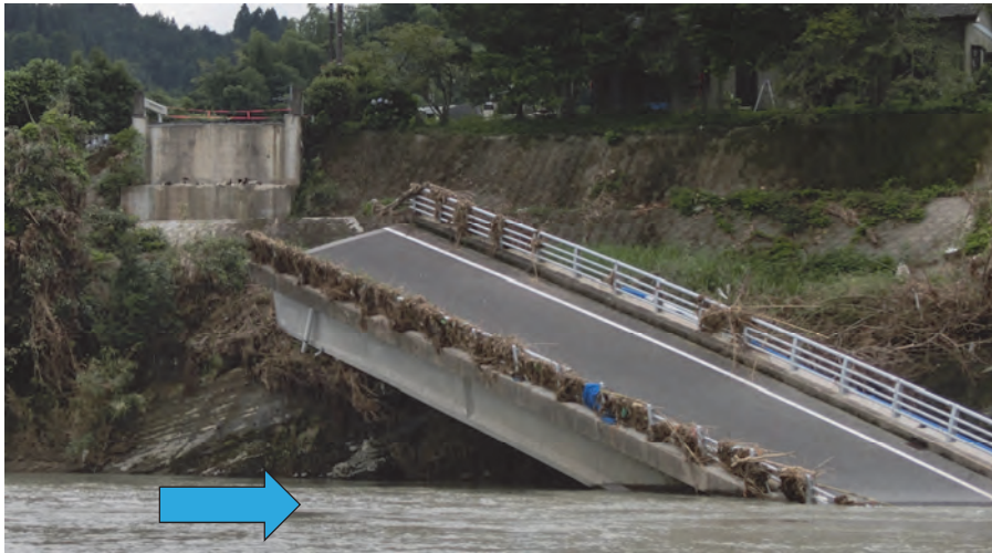
写真-3.1.69 橋座から流失した左岸側側径間（P3～A2 間）の桁
