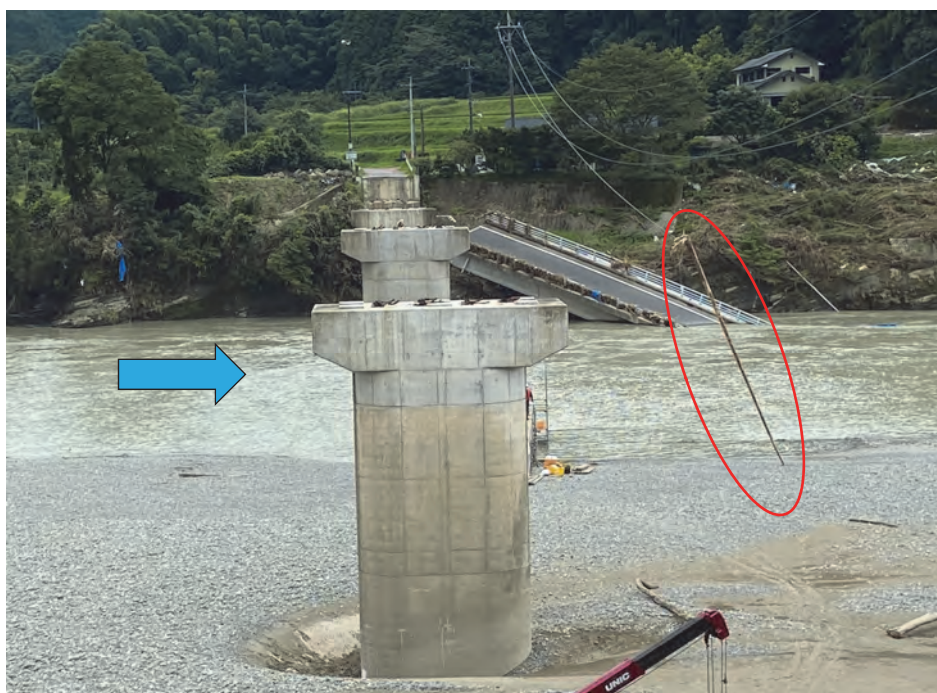
写真-3. 1. 79 架空線に絡まる流木（右岸側から臨む）
