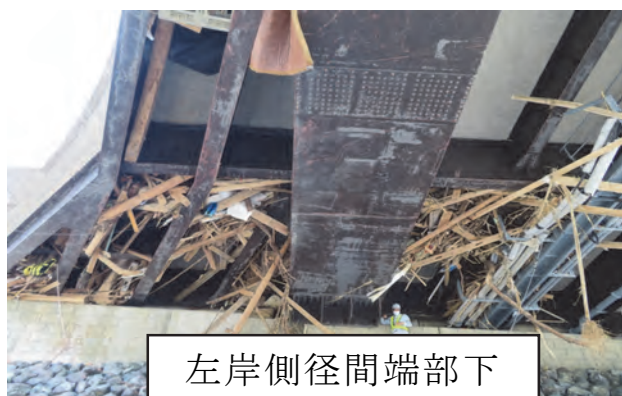
写真-3. 1. 55 桁下下面の状況及び支承部の状況
