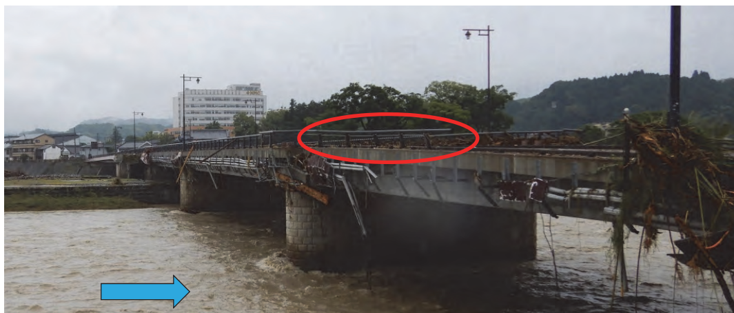
写真-3.1.99 防護柵及び桁カバーの損傷（右岸上流側）
