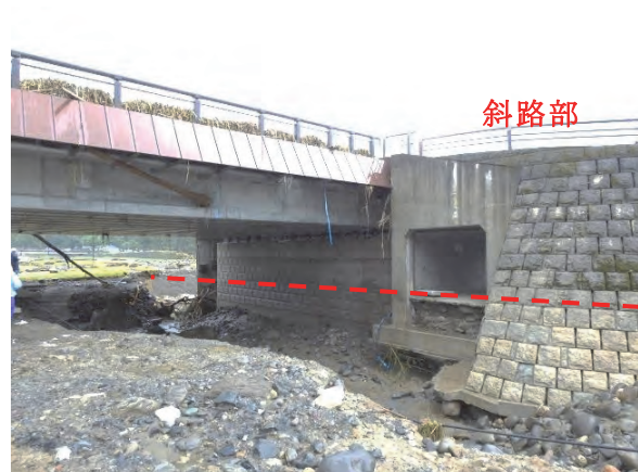
写真-3.1.107 階段部の下流側の洗掘状況
