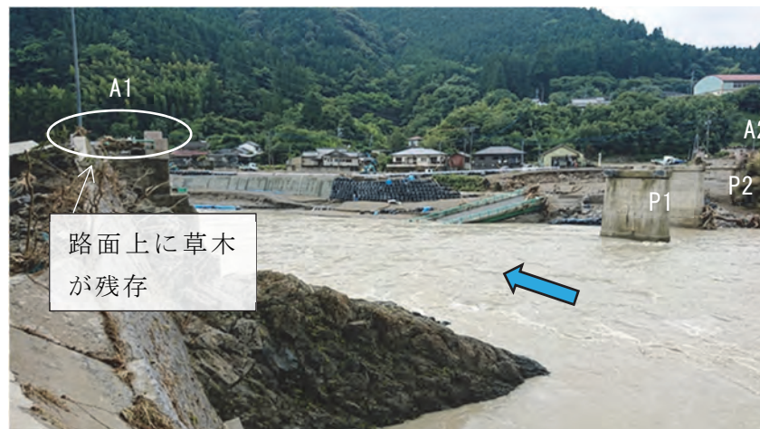
写真-3.1.14 上部構造の流失
