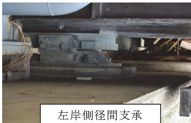
写真-3. 1. 55 桁下下面の状況及び支承部の状況
