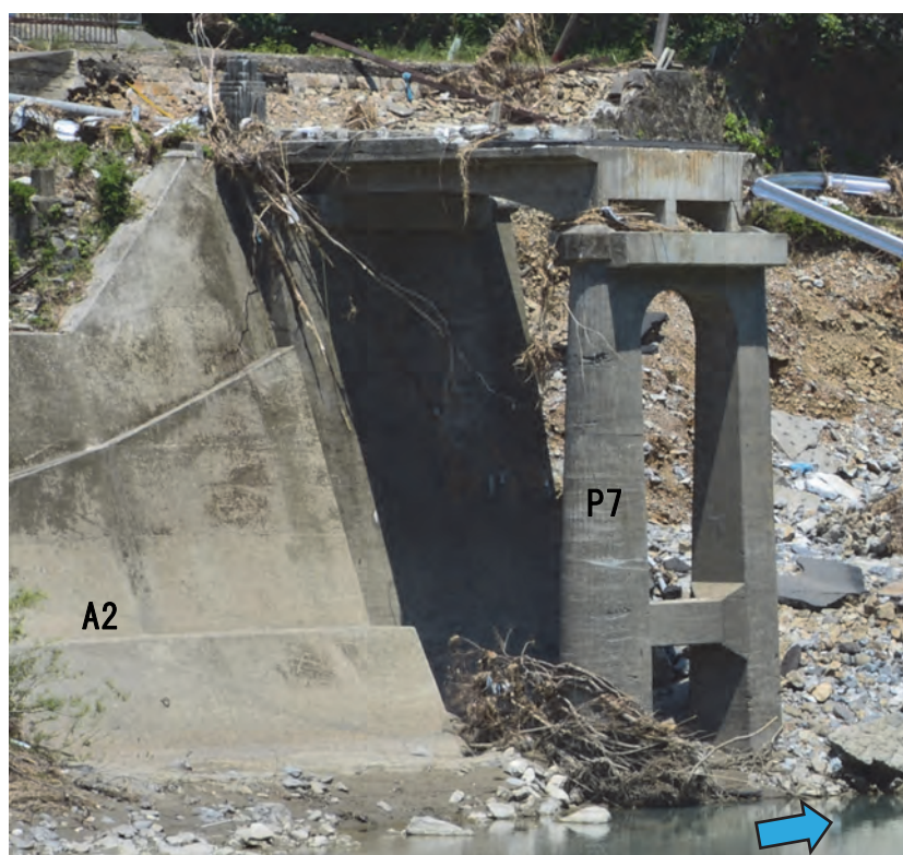
写真-3. 1. 28 P7 橋脚及び A2 橋台の状態
