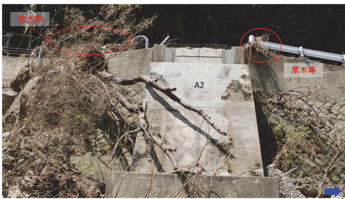
写真-3.1.49 A2 橋台の周辺の水位の痕跡（A1 側から撮影）
