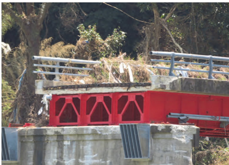
写真-3.1.62 残存した I 桁橋の高欄に流木や浮遊物が詰まった状況
