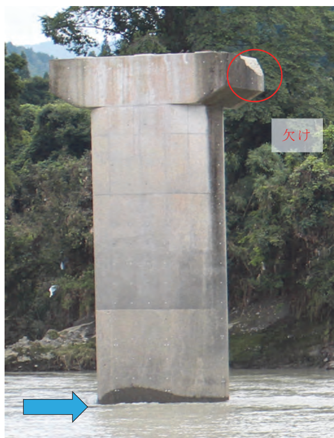
写真-3. 1. 77 梁部の欠け (P3) (下流側から臨む)
