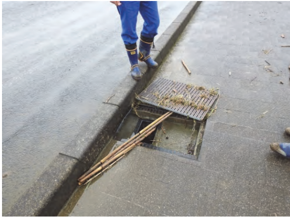
写真-3.1.104 排水溝の蓋の外れ
