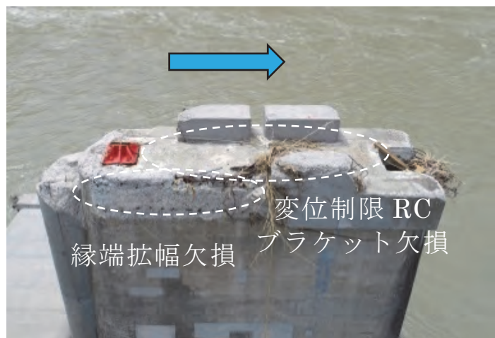
写真-3. 1. 10 P1 橋脚損傷状況
