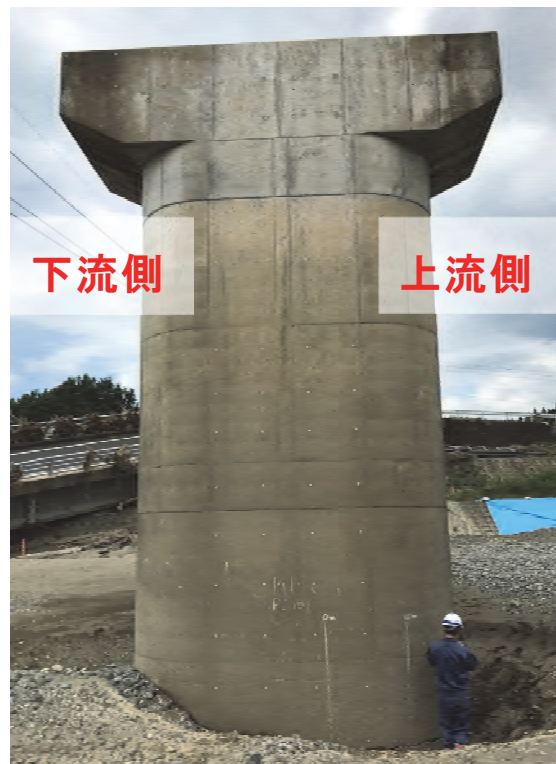
写真-3.1.75 洗掘及び下流側への傾斜が確認された P1（左岸側から臨む）
