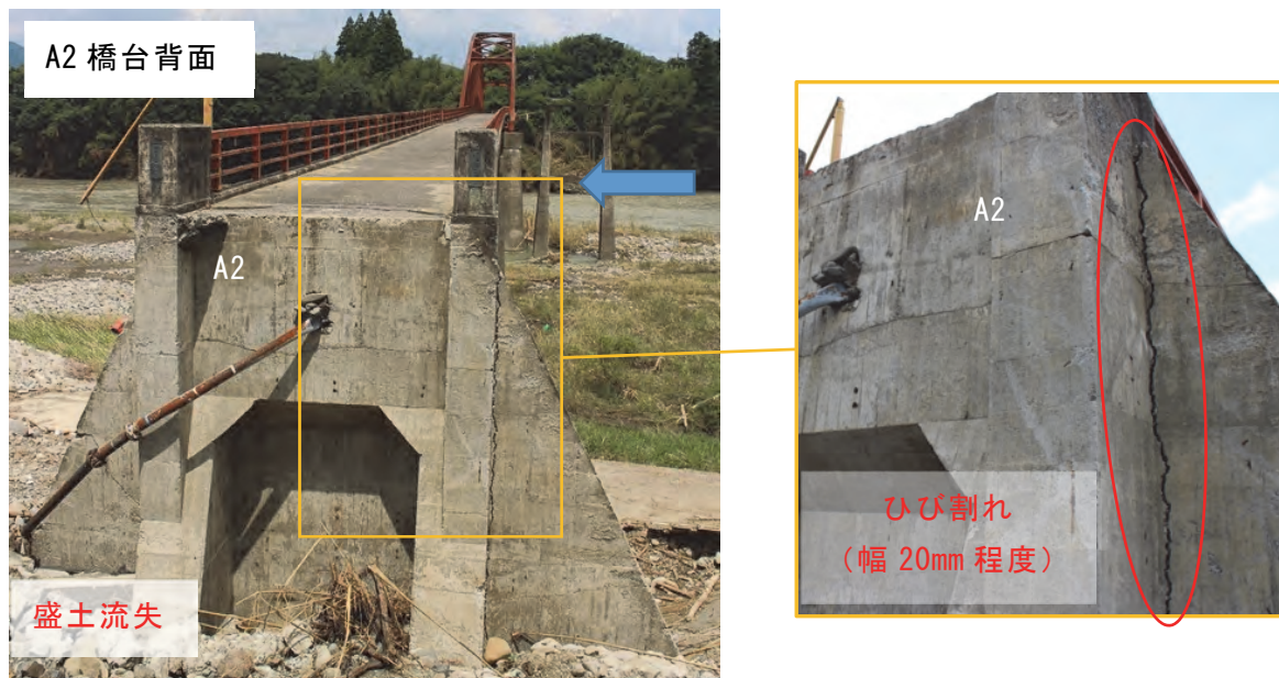
写真-3.1.84 A2 橋台背面側のウィング接合部のひび割れ
