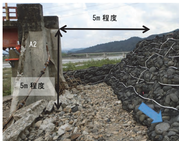
写真-3.1.82 A2 橋台背面盛土流出状況（下流側より撮影）
