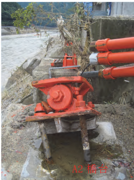
写真-3. 1. 9 側道橋 A2 支承部損傷 状況
