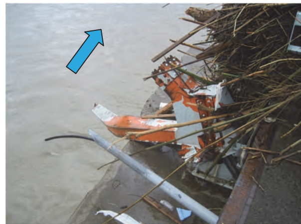
写真-3.1.93 P2 橋脚下流側の支承とトラス格点（7月10日撮影）
