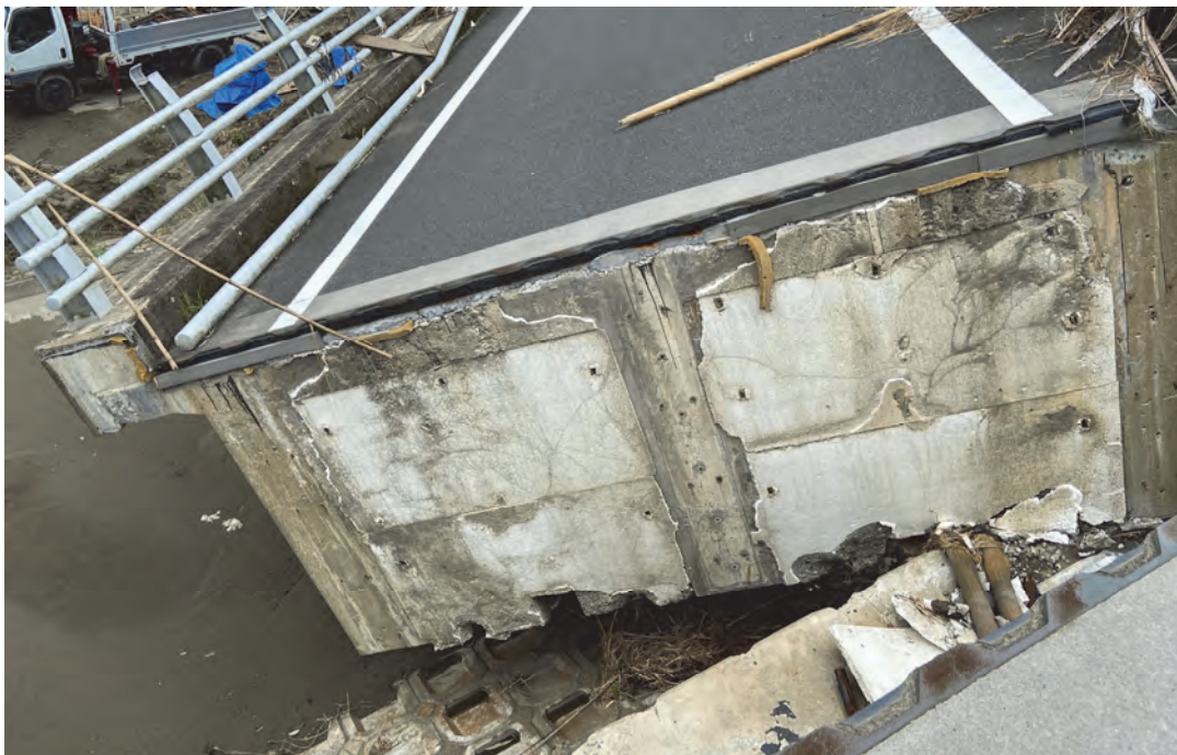
写真-3.1.68 右岸側側径間（A1～P1 間）の桁の落下
