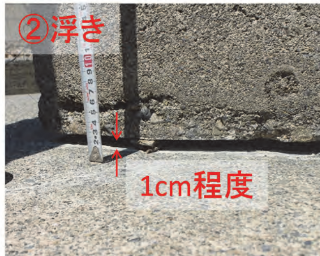
写真-3.1.41 P2 橋脚基部の浮き上がりの状況（A1 側から撮影）
