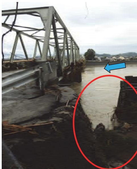
写真-3.1.97 A2 橋台上流側の護岸と背面土の流出
