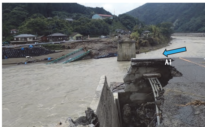
写真-3.1.16 A1 橋台のパラペット及びウイングの損傷状況
