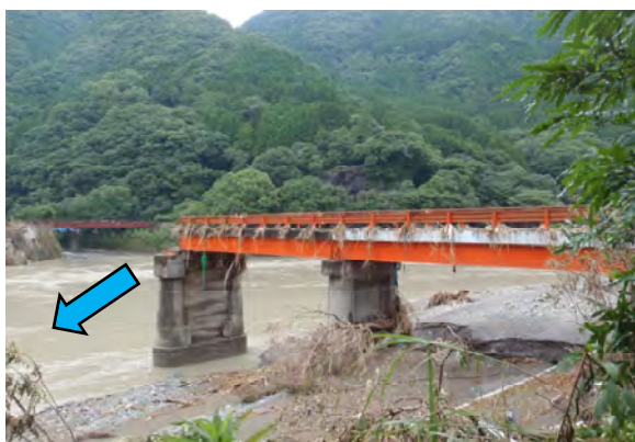
写真-3. 1. 5 被災直後の P3～A2 桁
