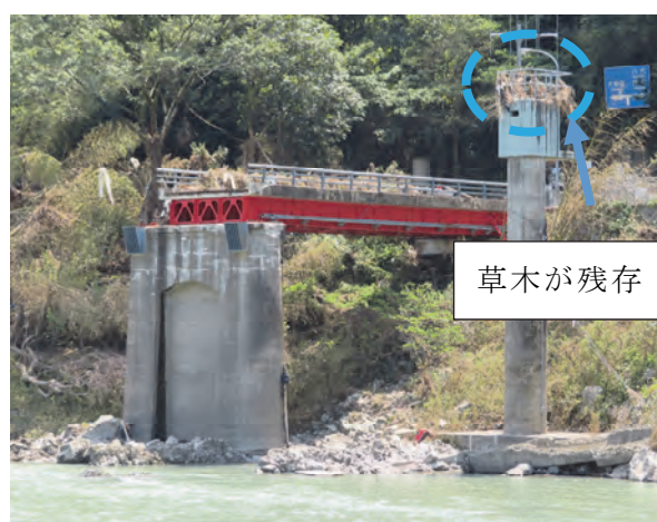
写真-3.1.61 A1～P1 間 残存する I 桁
