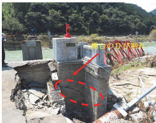
写真-3.1.60 A2 橋台の背面状況
