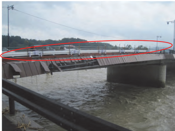
写真-3.1.108 応急復旧された防護柵 (右岸下流側) (7月10日撮影)
