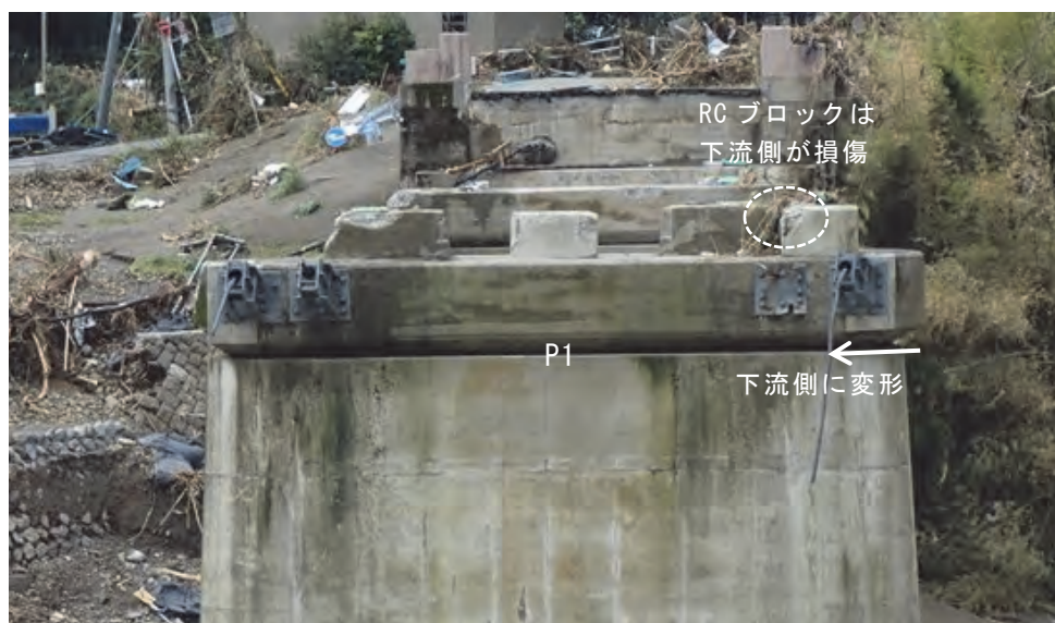
写真-3.1.18 橋脚上の落橋防止のケーブルの破断
