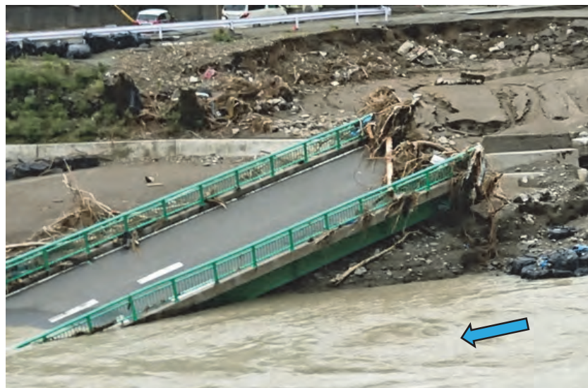
写真-3.1.15 流失した上部構造（鋼 I 桁橋）の状況
