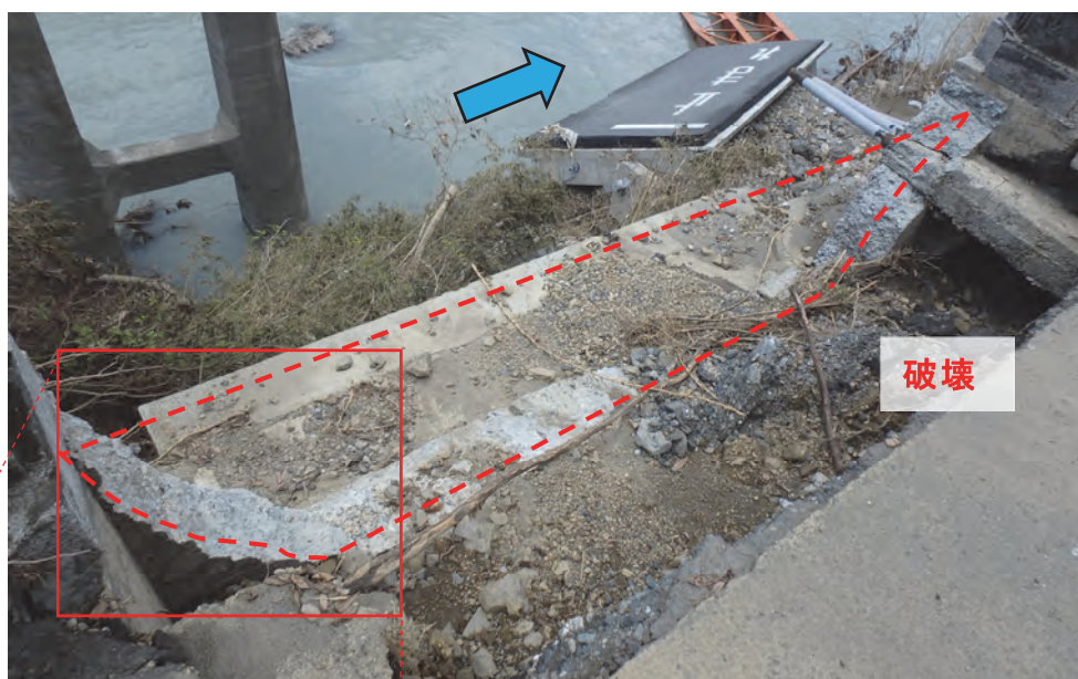
写真-3.1.26 A1 橋台パラペットの変状
