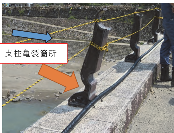
写真-3.1.53 支柱基部で損傷した上流側の防護柵
