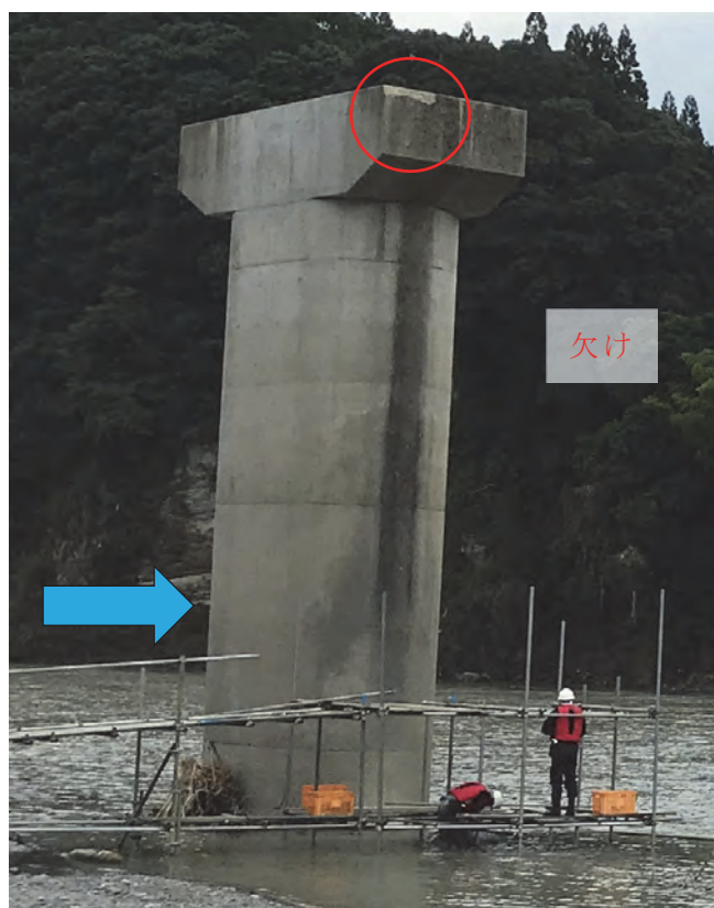
写真-3. 1. 76 梁部の欠け (P2) (下流側から臨む)
