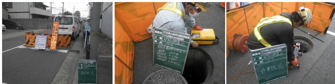
図 2-13 点検直視型カメラの調査手順
