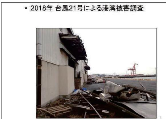
次に、実際の被災調査について紹介させていただきます。倉庫が越波によって被災を受けています。倉庫の前にあるのが防潮扉になります。これが本当は波を防ぐはずだったのですが、越波によって著しく破壊されているのが分かるかと思います。
