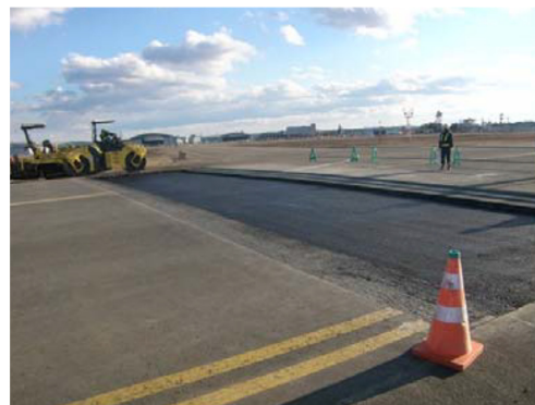
打替え事例(2011年仙台空港誘導路)
