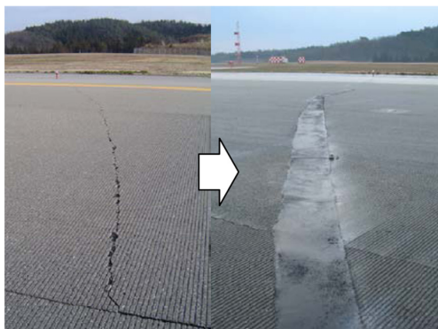
摺り付け事例(2007年能登空港滑走路)
