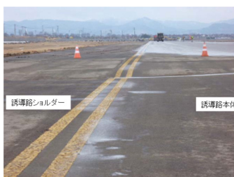
仙台空港の誘導路(アスファルト舗装)の液状化による局所沈下
