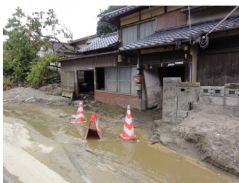
平成29年7月九州北部豪雨(筑後川水系赤谷川)
