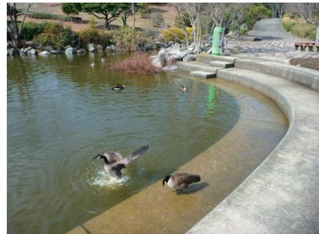
素掘りによって整備した池で、池の水位は地下水位そのものである。このため、季節によって水位が変動するため、護岸は階段状にデザインされている。整備が進んでいる「森の池エリア」は、前記の素掘りの池と同じ理由で、降雨が続くと標高が低い箇所に現れる幻の池をそのまま公園施設として活用している。
