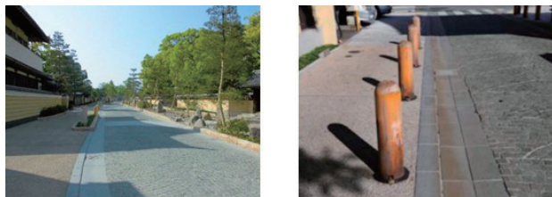
図-3 使い勝手に配慮した横断構成：セミフラット形式の歩道（左）と着脱式のボラード（右） 【福岡市承天寺通り】（※市提供）
