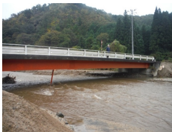
写真-5.2.10.15 岩下橋の桁下
