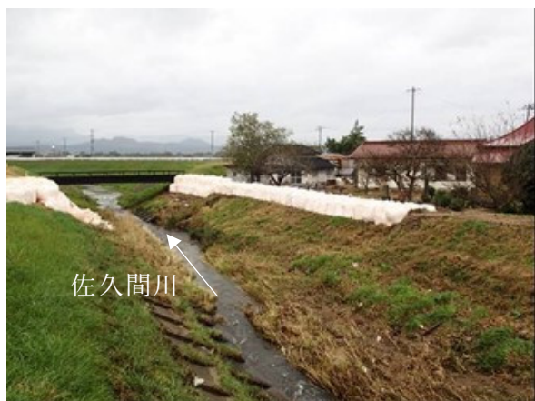
写真-5.2.5.29 佐久間川 決壊箇所
