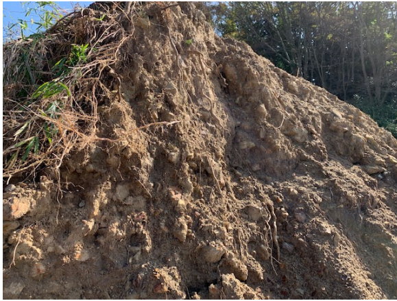
写真-5.2.12.19 下流側堤防断面
