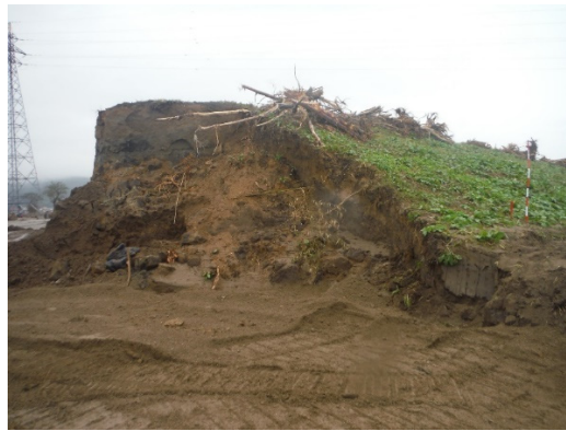
写真-5. 2. 10. 29 堤防の断面
