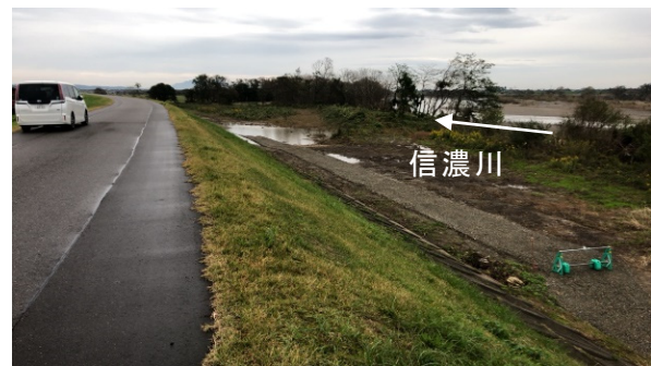
写真-5.2.11.2 信濃川左岸 12.6KP
