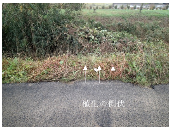
写真-5.2.5.26 滝川 直上流
