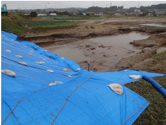
写真-5.2.5.35 谷田川 落堀
