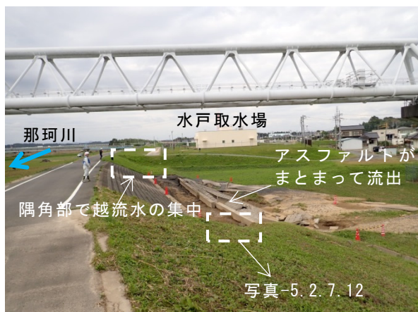
写真-5.2.7.10 水管橋条件護岸の被災状況 那珂川左岸 19.3KP 下流から
