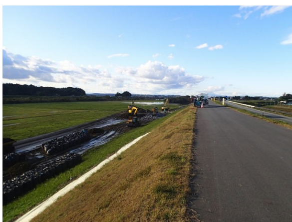
写真-5.2.5.9 鳴瀬川左岸 8.4～8.8KP 上流端
