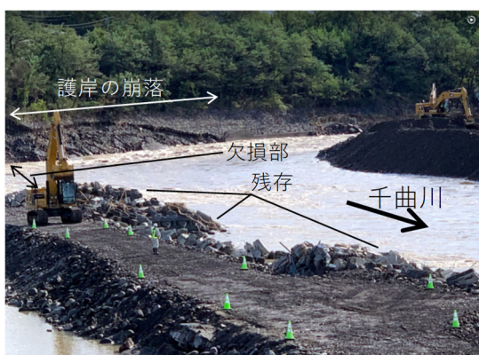
写真-5.2.9.5 仮設道路上流部分
