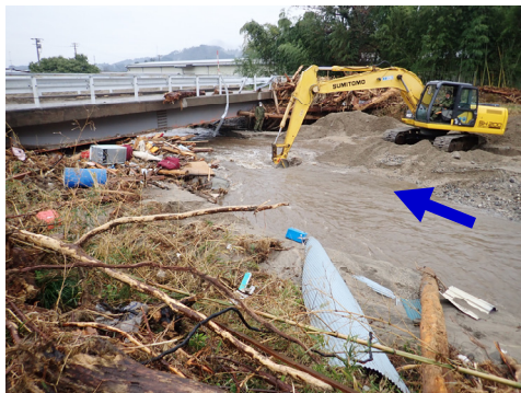
写真-5. 2. 10. 18 河道内の浚渫の様子
