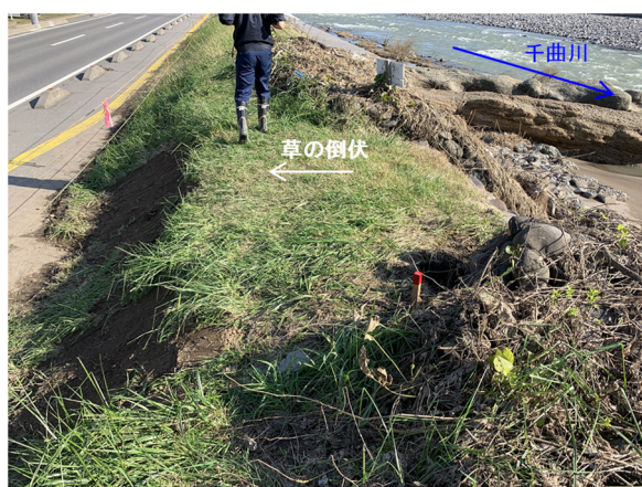
写真-5.2.13.20 千曲川右岸 107.0KP 天端・裏法越流侵食状況
