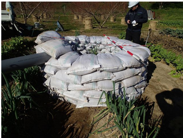
写真-5.2.18.38 阿武隈川上流左岸 10.7KP 釜段
