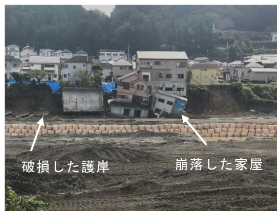
写真-5.2.16.2 秋川秋留橋下流左岸から
