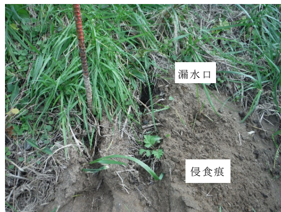
写真-5.2.17.7 阿武隈川下流左岸17.4KP (漏水口と侵食痕)
