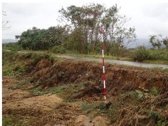
写真-5.2.5.27 滝川 約 100m 上流越流痕跡
