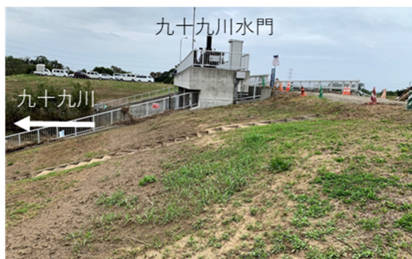
写真-5.2.3.5 九十九川水門を下流から望む
