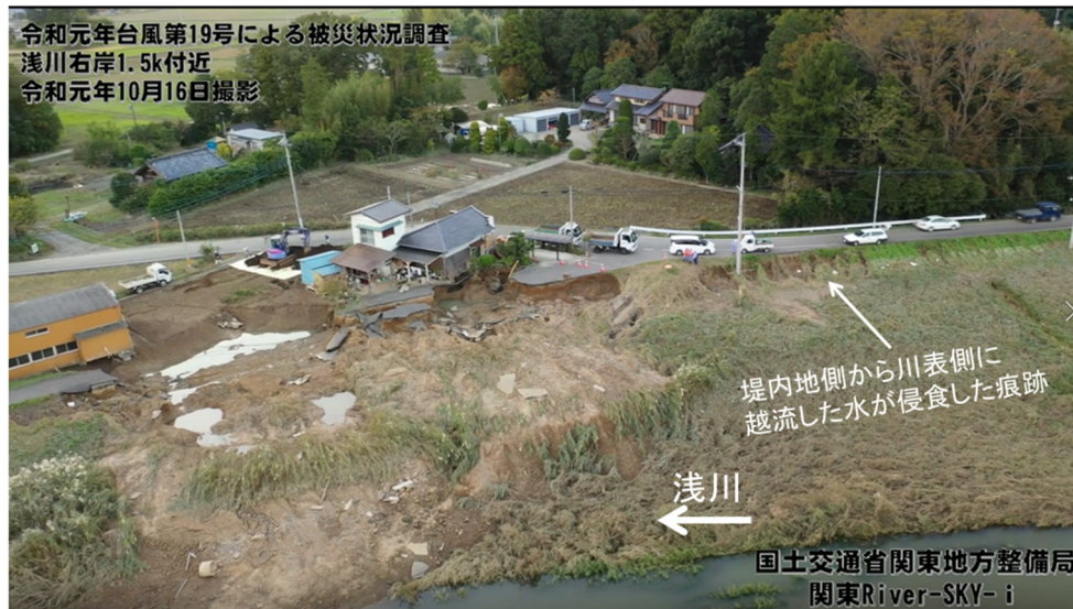
写真-5.2.6.10 浅川右岸 1.5km 被災状況（関東地方整備局 17) ）
