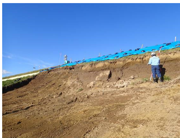
写真-5.2.5.8 鳴瀬川左岸 8.4～8.8KP 被災区間下流端滑落崖
