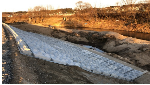
写真-5.2.19.10 谷田川左岸 川表復旧状況
