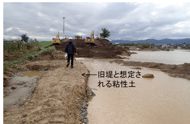
写真-5.2.1.3 堤防表法尻(基盤粘性土の状況)
