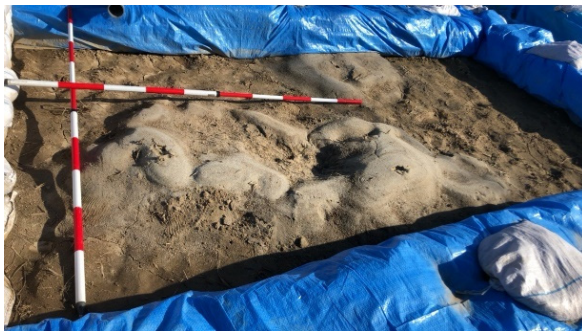
写真-5.2.18.17 阿武隈川下流左岸 18.0KP 釜段設置状況その 2
