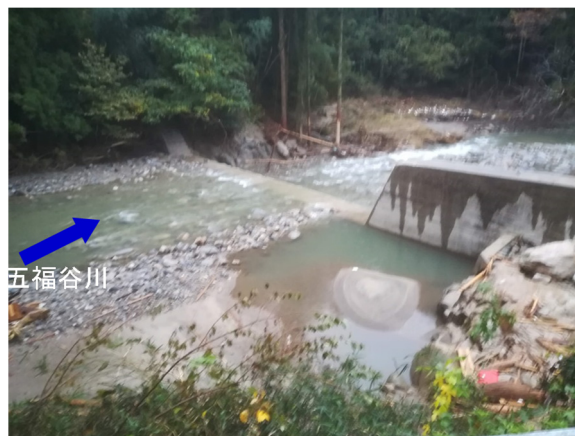
写真-5.2.10.14 満砂状態の砂防堰堤
