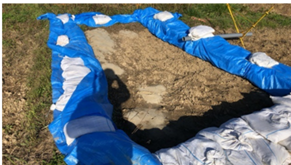
写真-5.2.18.19 阿武隈川下流左岸 18.0KP 釜段設置状況その 4
