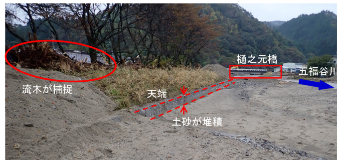
写真-5. 2. 10. 19 樋之元橋下流
