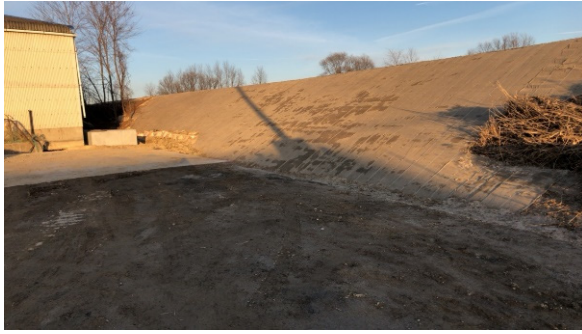
写真-5.2.19.9 谷田川左岸川裏復旧状況
