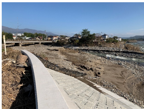
写真-5.2.13.21 千曲川右岸 107.0KP 神川合流点河道内堆砂状況
