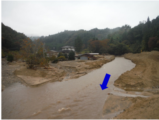
写真-5. 2. 10. 16 岩下橋上流側
