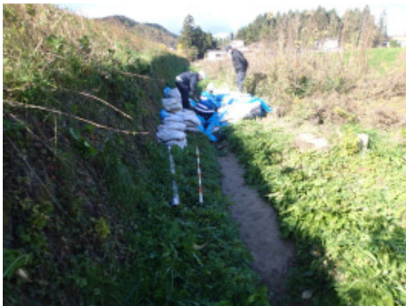
写真-5. 2. 18. 30 阿武隈川下流左岸 36. 6KP 月の輪工と堤脚水路
