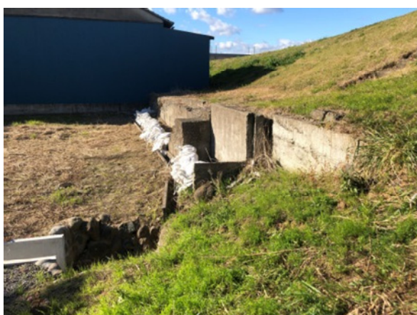
写真-5. 2. 18. 40 荒川右岸 0.2KP 川裏腰留め擁壁
