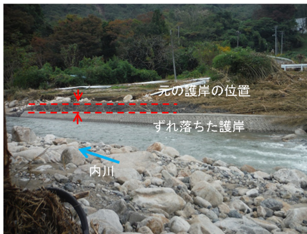
写真-5.2.10.5 馬越道大橋下流の護岸
