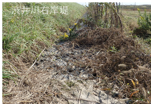
写真-5.2.12.4 渋井川 a 地点決壊箇所から 約 80m 下流の堤防法尻 (ドレーン)
