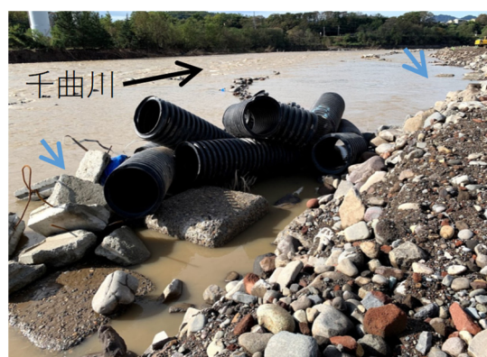
写真-5.2.9.6 仮設道路下流部分
