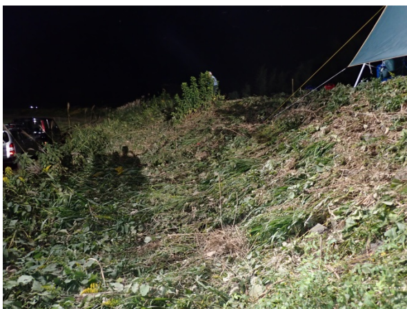
写真-5.2.4.28 周辺の裏法植生倒伏状況
