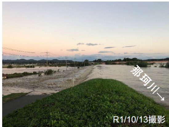
写真-5.2.4.1 越流状況 （関東地方整備局 13) ）
