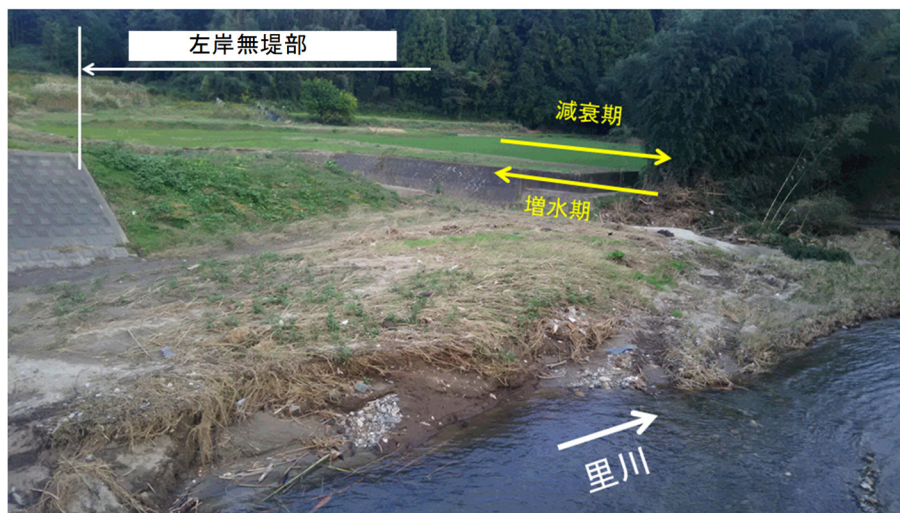
写真-5.2.6.12 左岸無堤部状況
