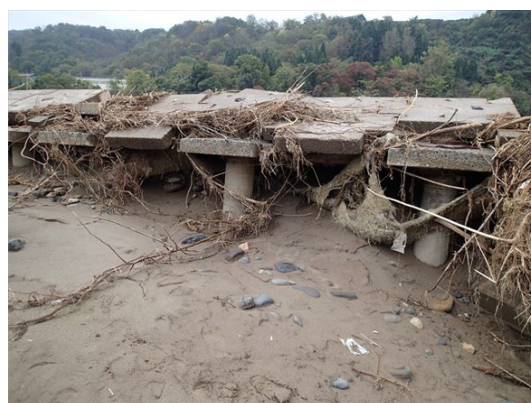
写真-5.2.11.10 信濃川右岸 37.0KP 変状の大きな護岸の状況
