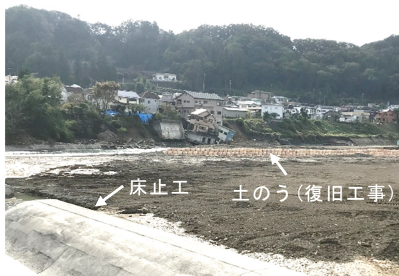
写真-5.2.16.1 秋川秋留橋下流左岸から
