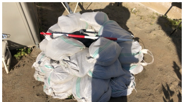
写真-5.2.18.4 阿武隈川下流左岸 5.0KP 釜段その 2
