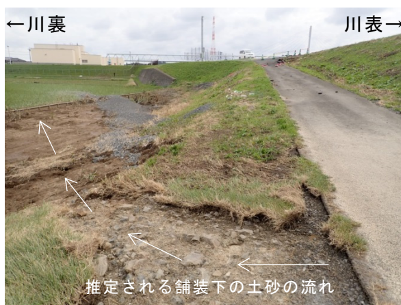
写真-5.2.7.16 舗装下の土砂の流れ（推定） 那珂川左岸 19.5KP 上流から
