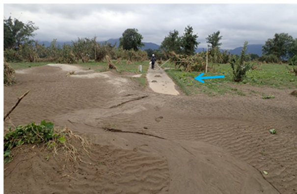
写真-5.2.1.7 決壊地点前面高水敷
