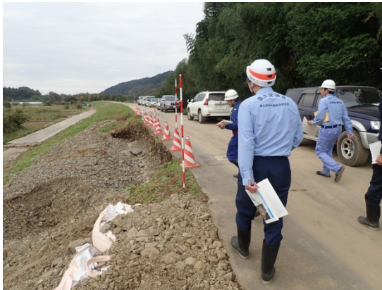
写真-5.2.4.9 決壊箇所近傍の裏法侵食状況 写真-5.2.4.10 堤防川裏法面の植生倒伏
