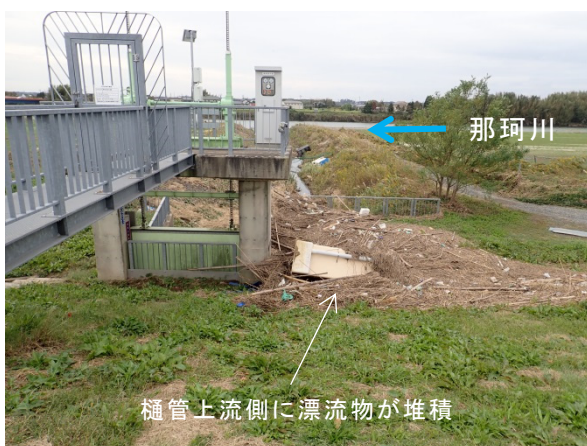
写真-5.2.7.5 樋管門柱の漂流物堆積状況 那珂川左岸 8.2KP 天端から
