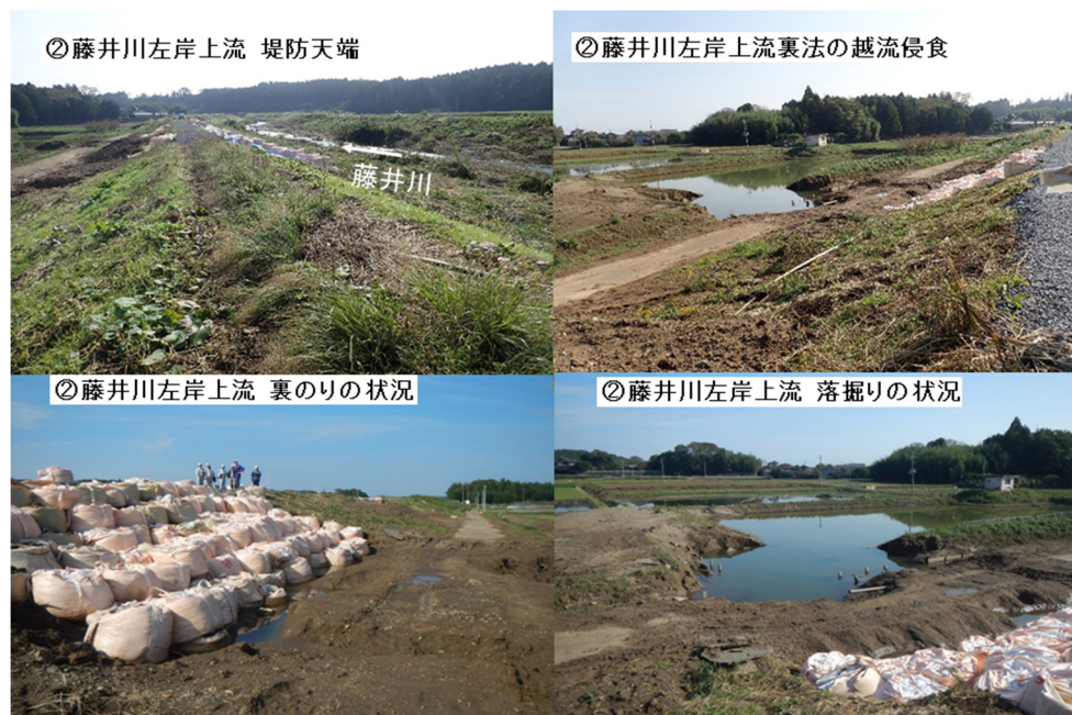
写真-5. 2. 14. 2 藤井川左岸上流の現地状況
