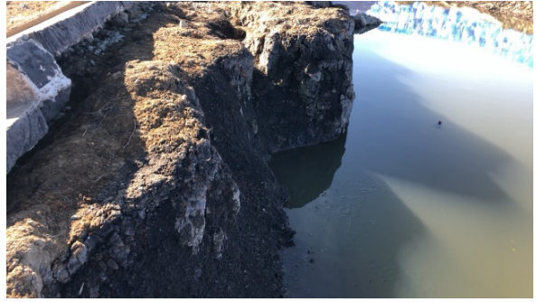
写真-5.2.19.4 高倉川左岸 護岸の基礎地盤
