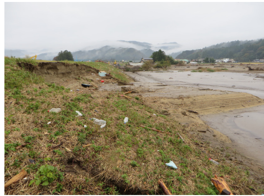
写真-5. 2. 10. 28 法尻の砂の堆積
