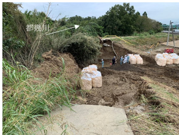
写真-5.2.3.15 決壊箇所応急復旧の状況
