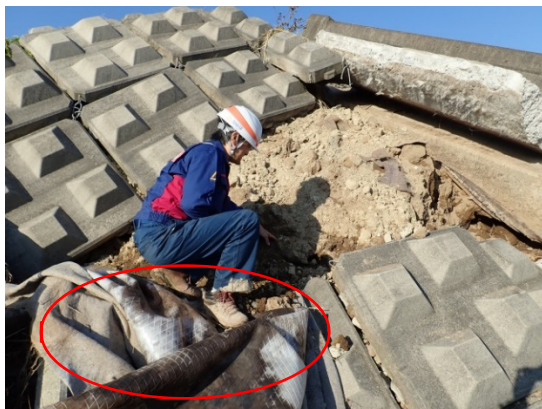
写真-5. 2. 2. 8 護岸と遮水シート
