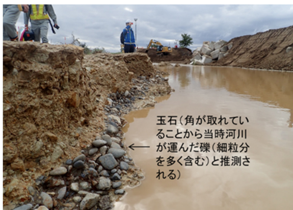
写真-5.2.1.2 堤防表法尻(礫層の状況)
