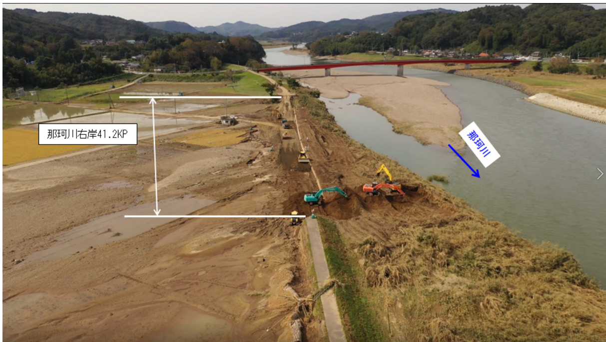
写真-5.2.4.13 決壊箇所下流の越流痕跡 (関東地方整備局 関東 River-SKY-i 15) )
