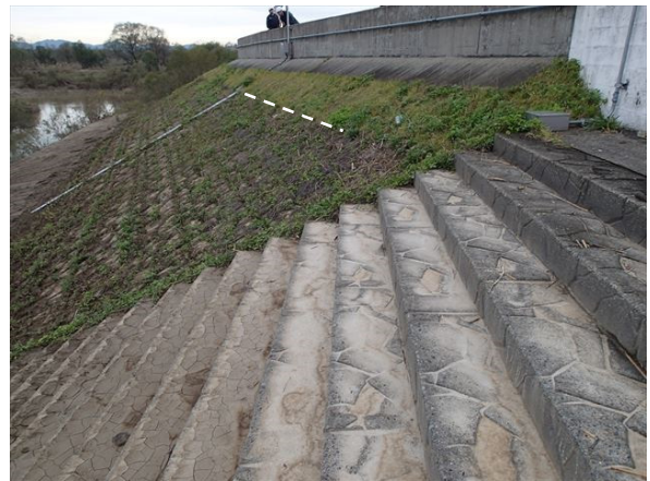
写真-5.2.11.6 信濃川右岸 15.3KP 痕跡水位
