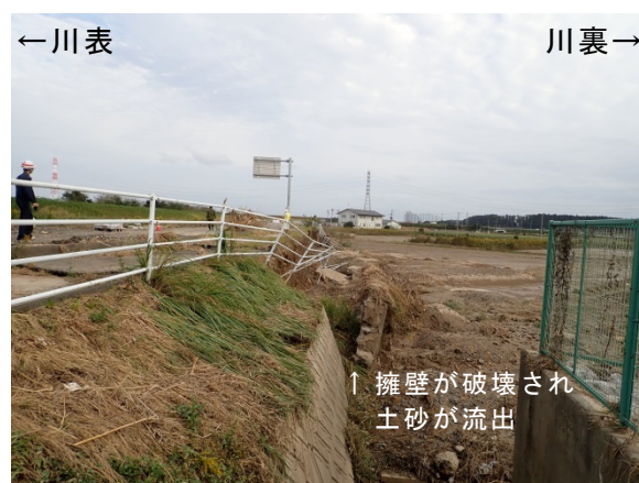
写真-5.2.7.24 法尻部の擁壁の被災状況 那珂川右岸20.5KP上流から
