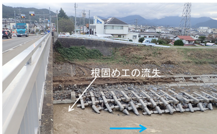
写真-5.2.1.17 上田橋左岸根固め
