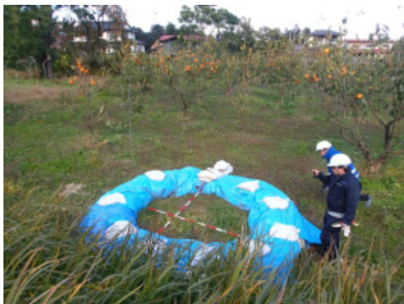
写真-5.2.18.32 阿武隈川下流左岸 37.0KP 釜段
