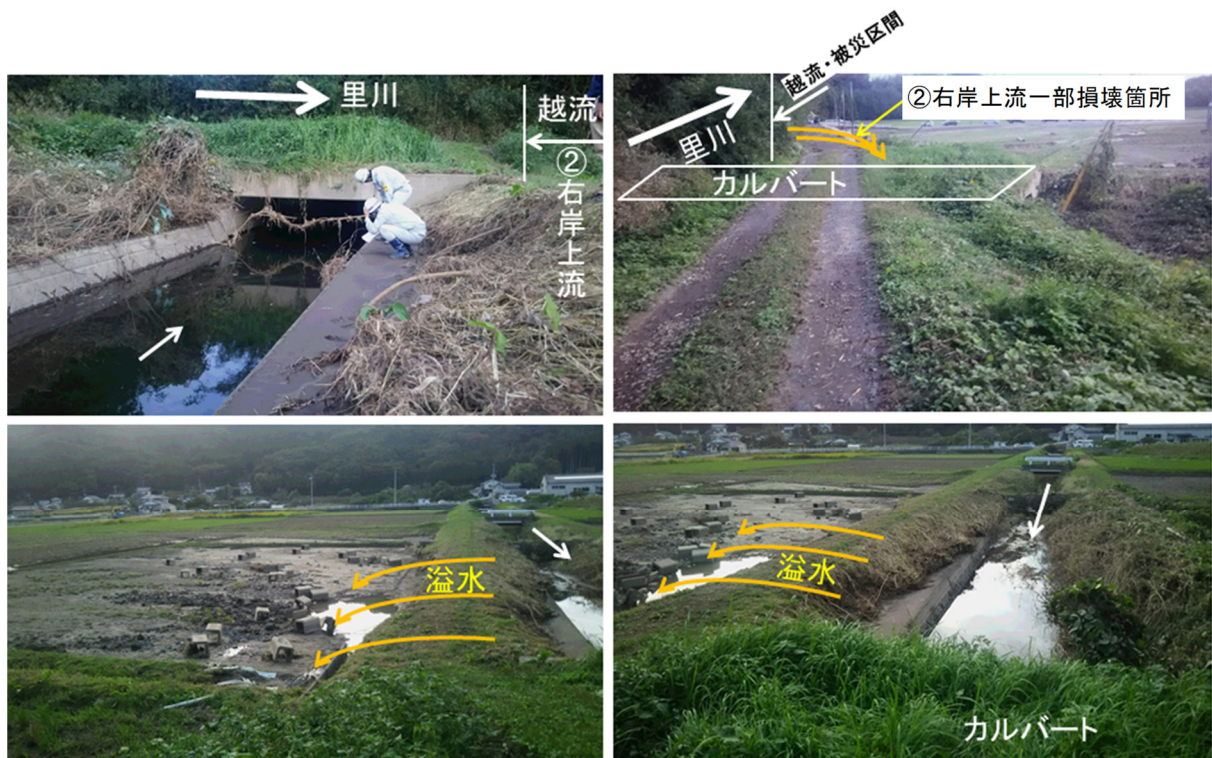
写真-5.2.6.14 ②右岸上流一部損壊と越流区間上流端カルバート付近の状況
