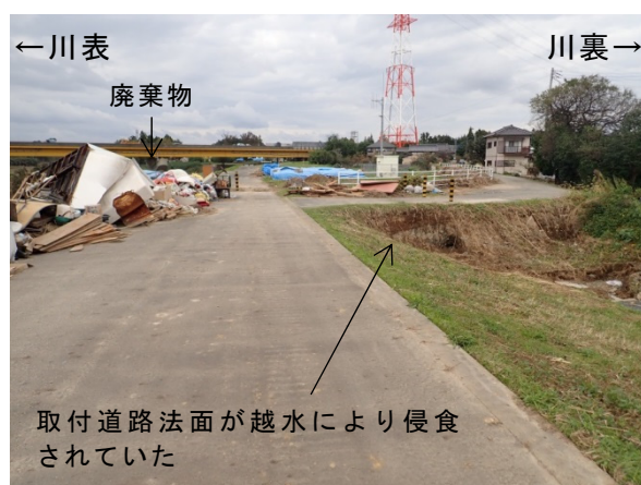
写真-5.2.7.20 取付道路法面の侵食状況 那珂川左岸 19.8KP 下流から
