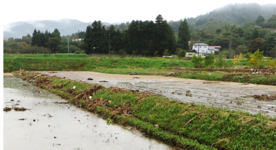
写真-5. 2. 10. 22 土砂の堆積状況
