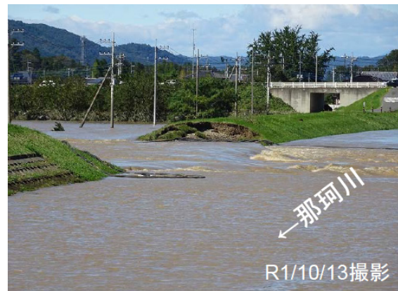
写真-5.2.4.2 決壊後の状況 （関東地方整備局 13) ）
