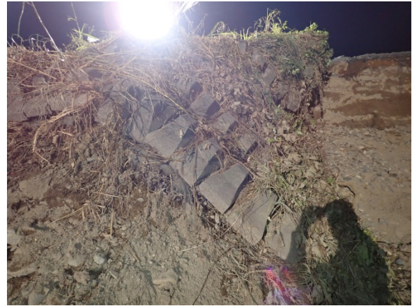
写真-5.2.4.26 裏法の連節ブロック
