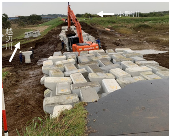
写真-5.2.3.3 応急復旧の様子
