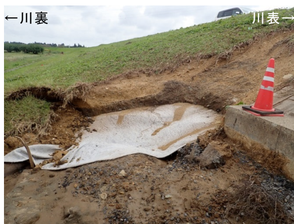
写真-5.2.7.12 侵食による吸出し防止シートの露出 那珂川左岸 19.3KP 上流から
