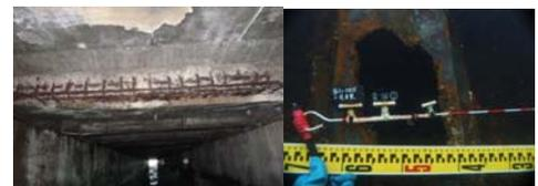
コンクリートの陥没/鋼矢板の欠損等の事例
