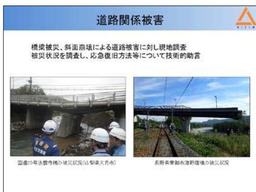
道路関係被害としては、橋梁の被災や斜面崩壊による被害が発生しております。左の写真は、山梨県の国道20号法雲寺橋、右の写真は、長野県東御市のしなの鉄道をまたぐ市道、海野宿橋の被災状況です。被災状況を調査し、被災後の橋の状態や応急復旧方法について地方整備局、地方自治体に対して技術的助言を行っております。
