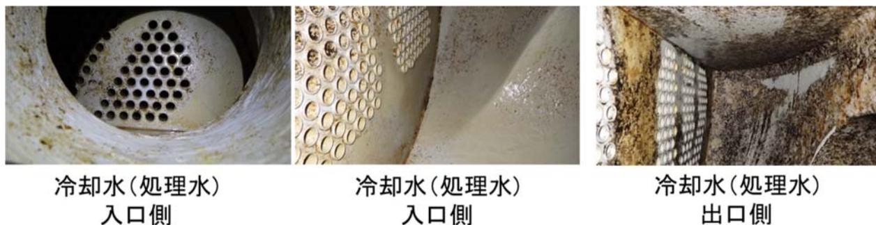
図資 1.3.2-1 復水器冷却水側の状況
