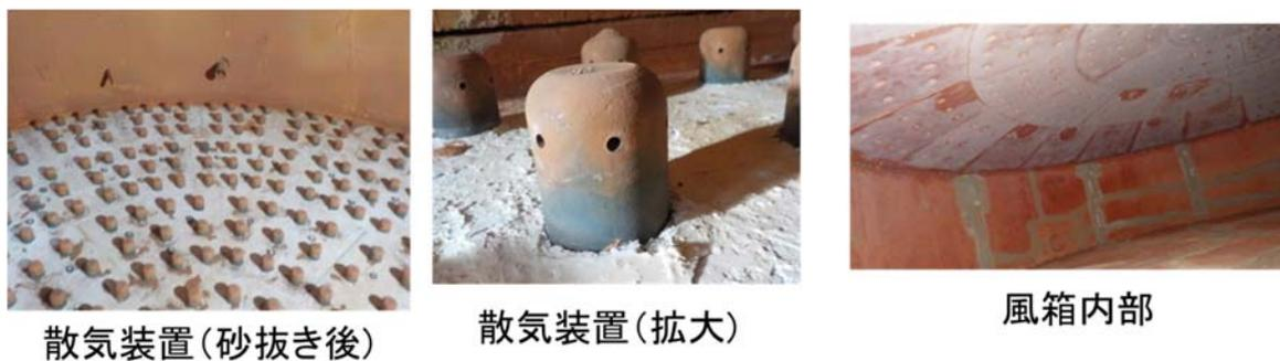
図資 1.3.3-3 炉内点検状況(清掃後 異常無し)
