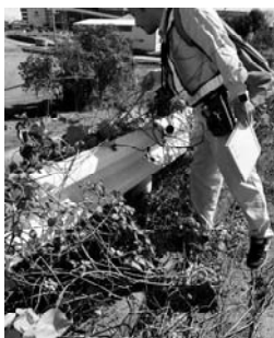
写真-1 打音の状況
