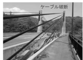
写真-1 橋が厳しいねじれの状況に陥る損傷の例
