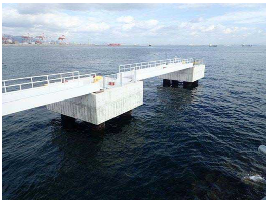
図-C6.3 ドルフィン及び渡橋の様子
