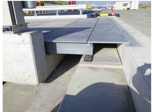
図-3.11 観測時の渡版の状況（護岸側）
