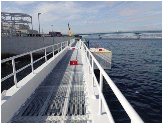
図-C6.2 ドルフィン間の渡橋の様子
