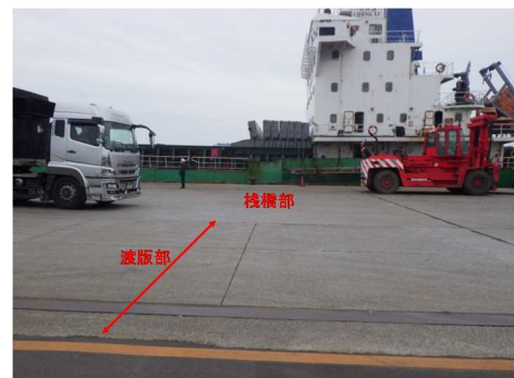
図-3.28 観測対象とした棧橋の状況（渡版部）
