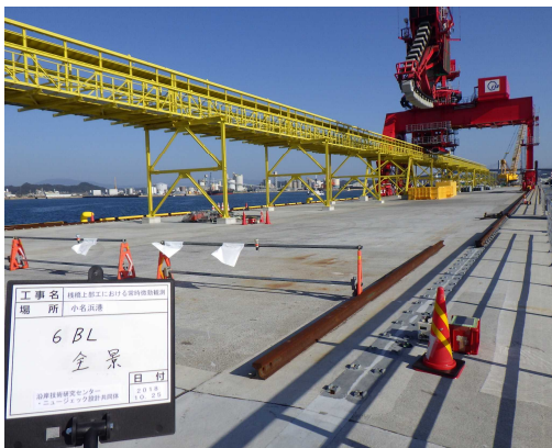
図-3.9 観測時の栈橋の状況（第6ブロック全景）
