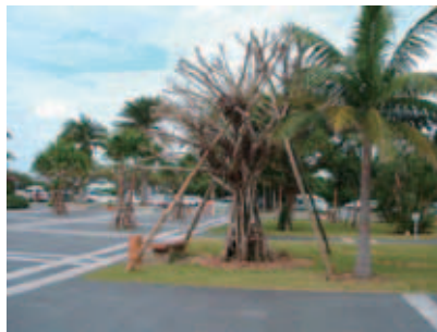
写真-5.18 支柱の再設置（樹木の大きさに適した規格への更新）
