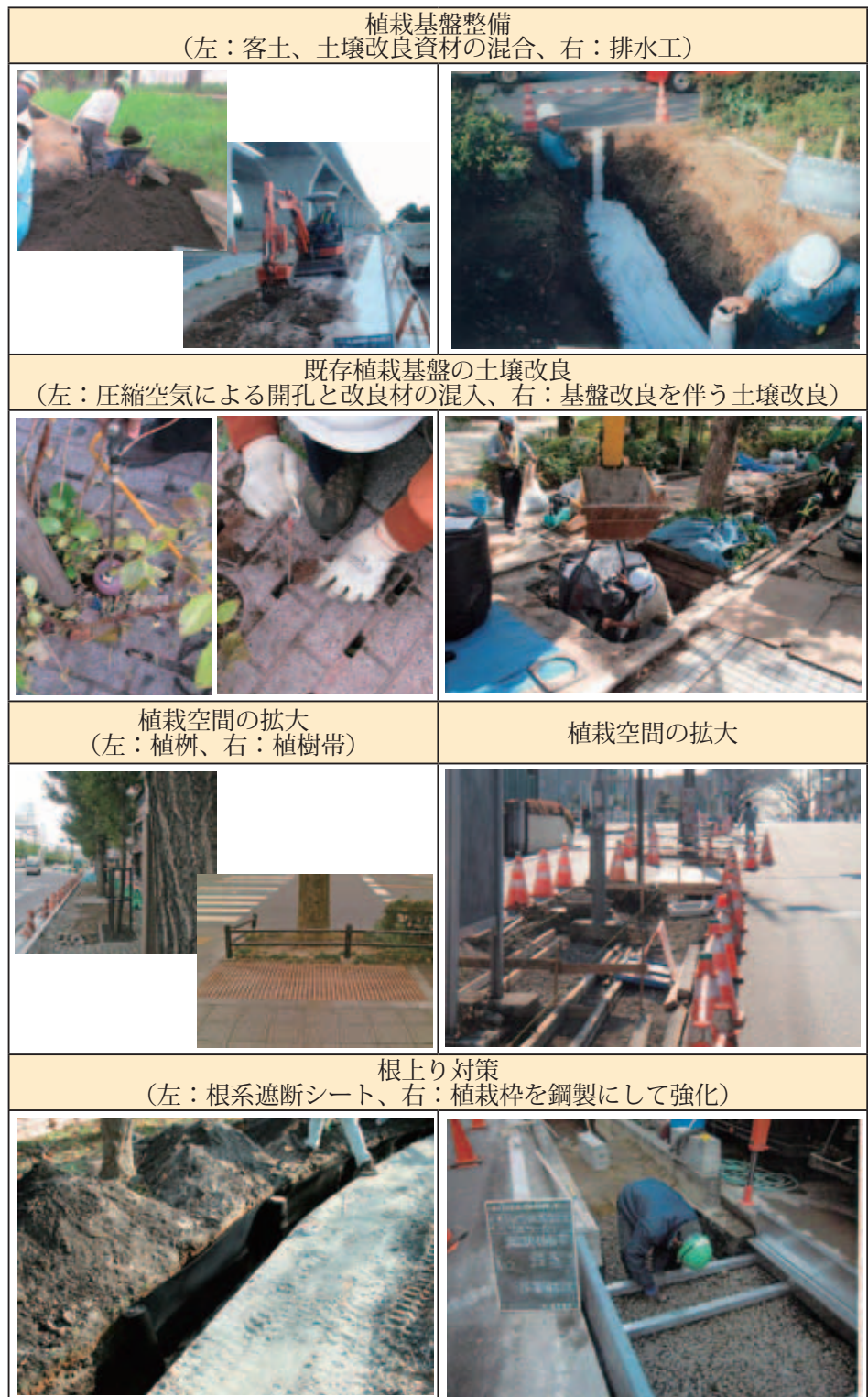
写真-5.7 植栽基盤整備・改良
