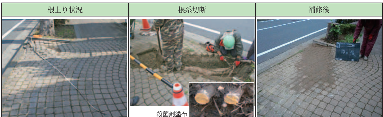
写真-5.12 根上りにより盛り上がった舗装の補修
