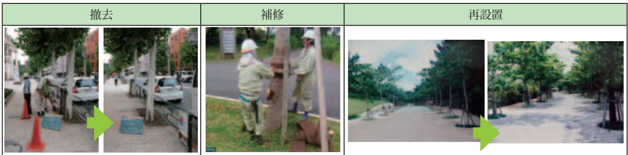
写真-5.11 支柱の撤去、補修、再設置
