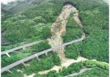
土砂崩落規模：幅約80m×長さ約230m×深さ約2.5m
