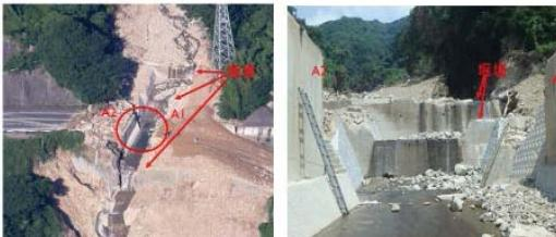
左側は航空写真、右側は橋があつた河床に降りて上流方向を撮影した写真です。橋の建設時期との関係は未確認ですが、橋の上下流に堰堤が設置されています。堰堤を乗り越えた土石流の高さと橋の床版の高さの関係で、丁度、流失してしまったとみられるところです。
