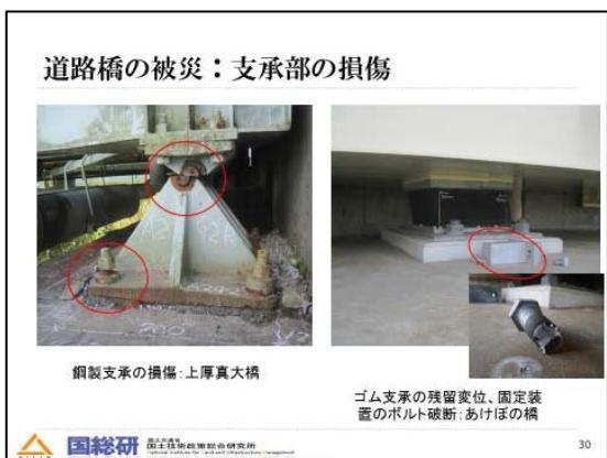
これらは、支承部の損傷です。上厚真大橋においては鋼製支承のピンが破損し、あければの橋ではゴム支承の移動制限装置のボルトが破断しています。
