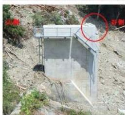
橋座部(天端)の谷側が欠損。他は軸体の損傷確認されず。山側面の検査路も健全。傾斜も確認されず。
