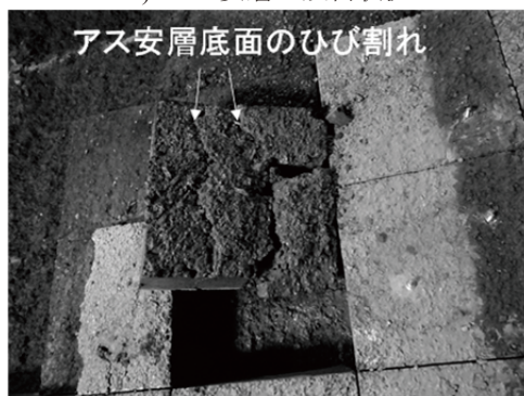
b) 貫通ひび割れにより崩壊した吊上げアスコン塊
