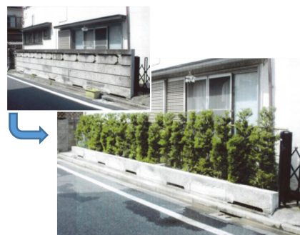
ブロック塀の撤去と生け垣化 （練馬区）
