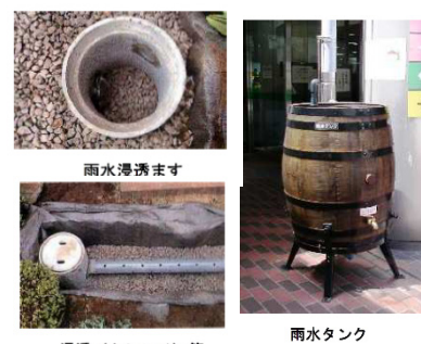
浸透（トレンチ）管
