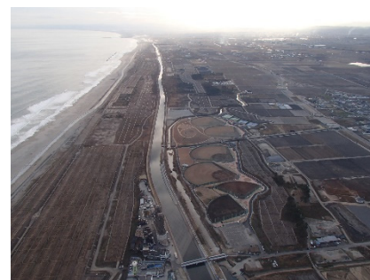
仙台地区海岸防災林 （仙台市）
