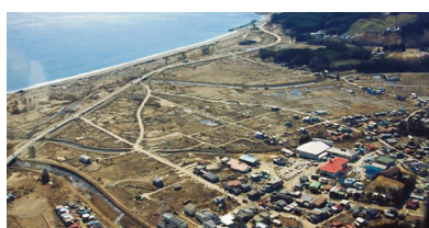
津波による被災状況
