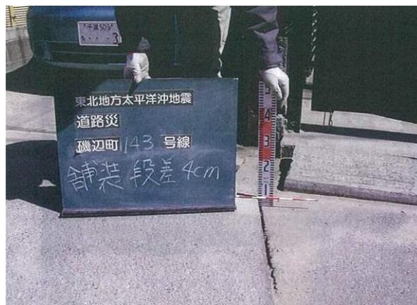
写真 2.2-1 被災写真（左：噴砂，右：段差）
