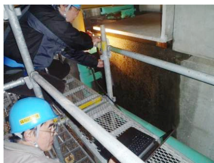
▲実験状況（調査機器は狭隘部外側）
