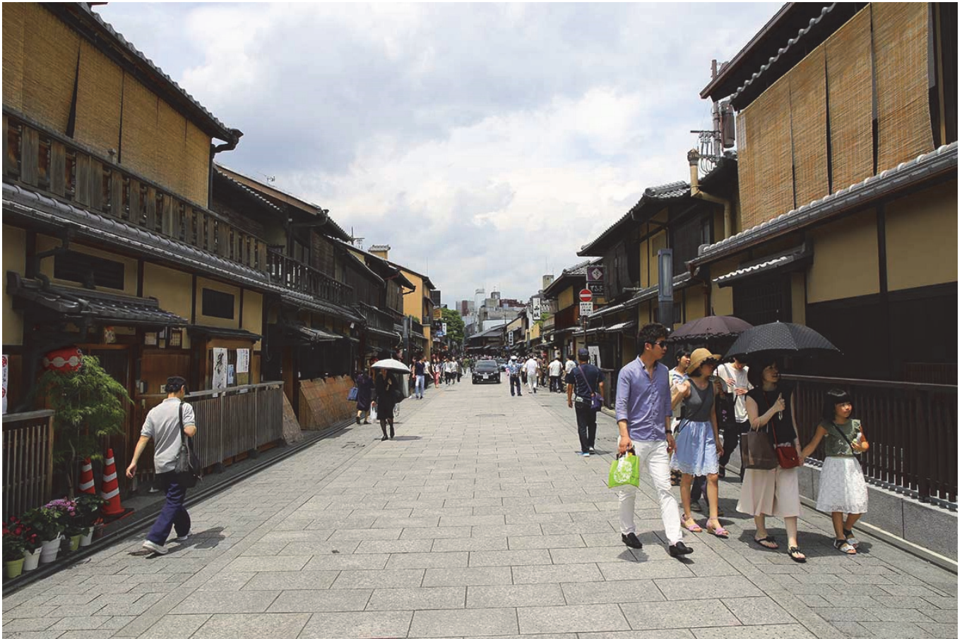
地域住民による町並み保存と連携しながら、無電柱化・舗装更新により歩行者中心の歩車共存型道路を整備 花見小路（京都府・京都市）
