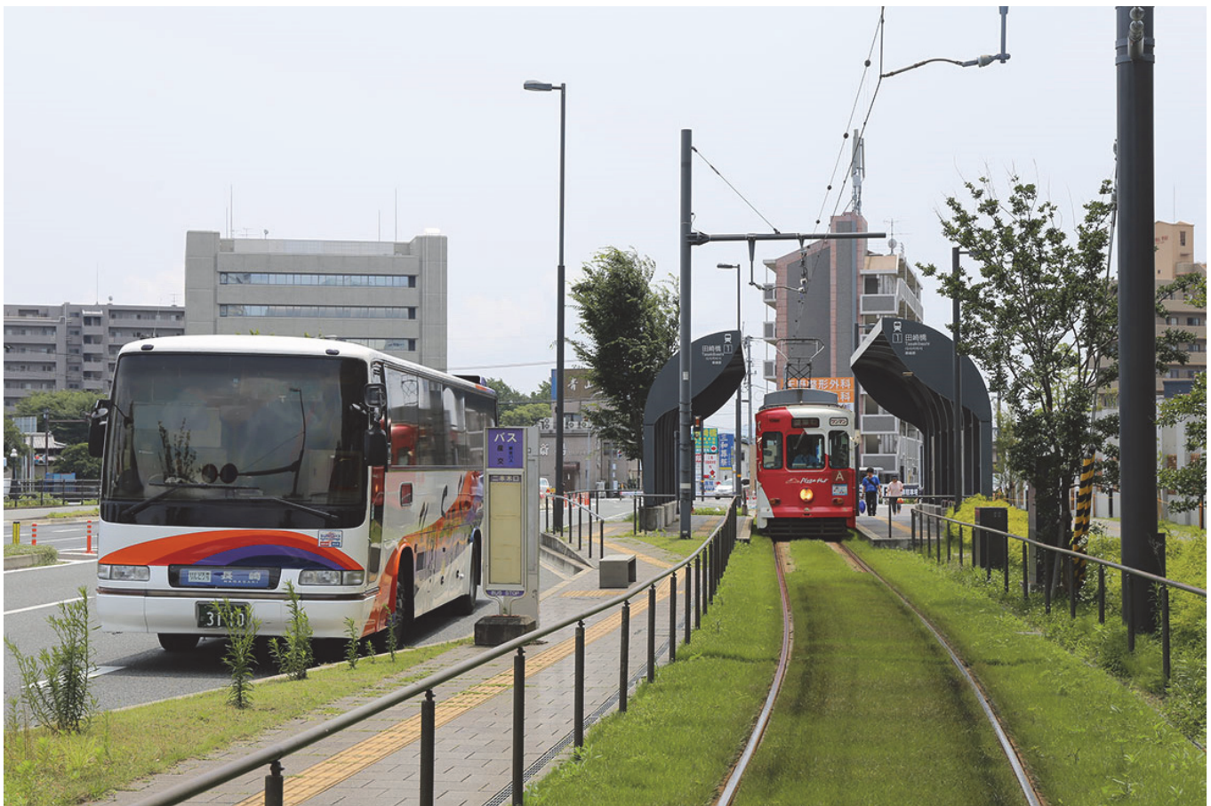
LRT 車両の導入と併せて、バス・鉄道との乗り換えや沿道施設とのアクセスに配慮したサイドリザベーション方式を導入 熊本駅城山線（熊本県・熊本市）
