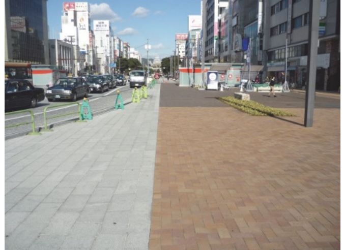
車道側に車道に準じた色の歩道舗装(兵庫県姫路市 大手前通り) 資料提供:姫路市
