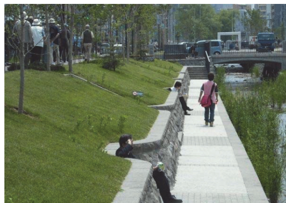
高低差の大きい区間では、川の流れを感じながら散歩できるよう、二段護岸を整備し、上部の護岸には着座可能なスペースを設置(北海道札幌市 創成川通) 資料提供:札幌市
