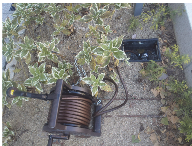
植栽用の散水栓を設置(愛媛県松山市 花園町通り) 資料提供:松山市
