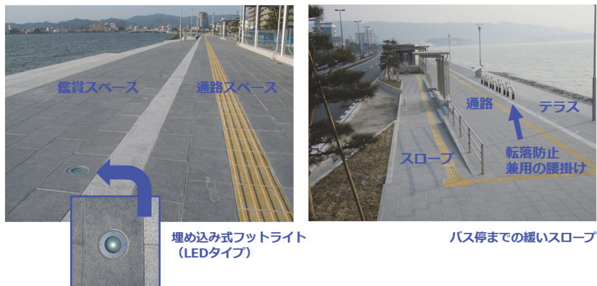
フットライトや舗装を用いて通行空間と滞留空間を視覚的に分離(島根県松江市 宍道湖夕日スポット) 資料提供:松江国道事務所
