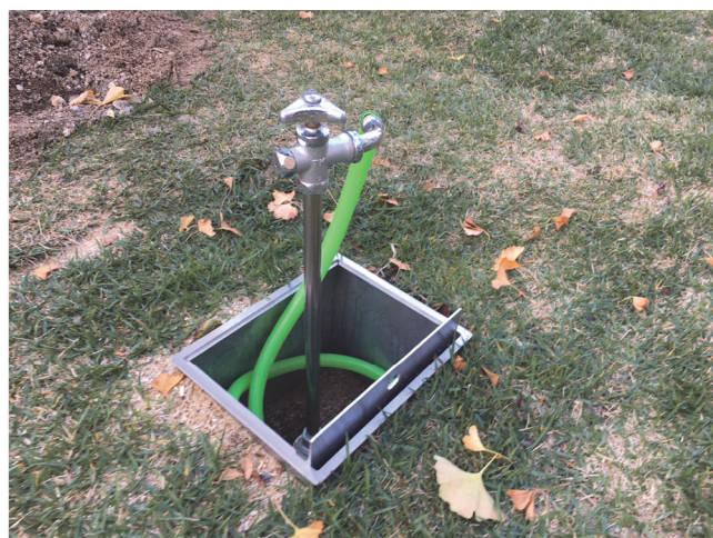
イベント時に利用するための収納型水栓(愛媛県松山市 花園町通り) 資料提供:松山市
