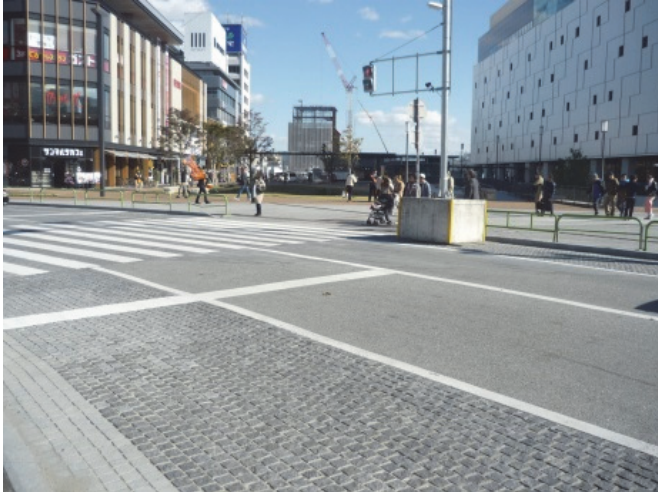
第一走行車線が石張り舗装の車道舗装
