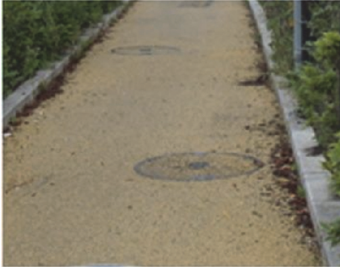
滑り止め加工を施したマンホールの蓋
