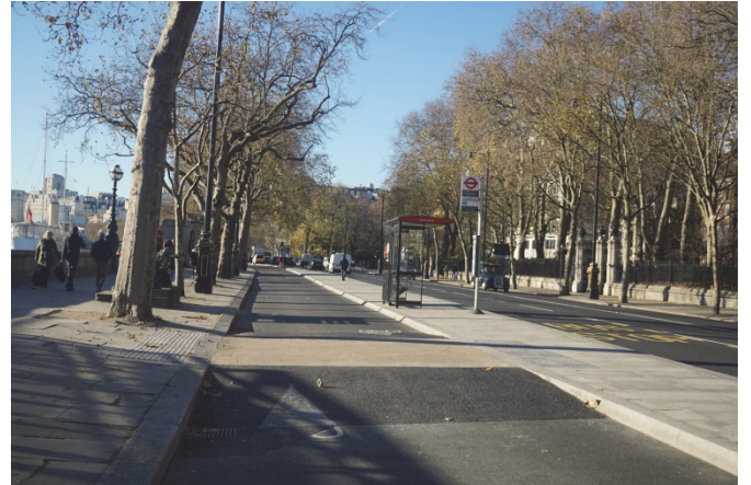
バス停留所と歩道の横断部は段差が生じないように処理 (イギリス ロンドン市 サイクル・スーパーハイウェイ)
