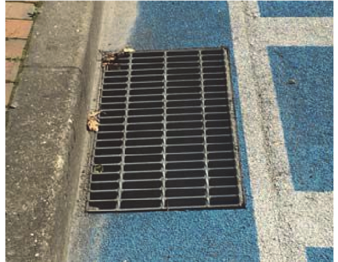
エプロン幅を狭くするために 格子の形状を工夫したグレーチング蓋 出典：安全で快適な自転車利用環境創出ガイドライン
