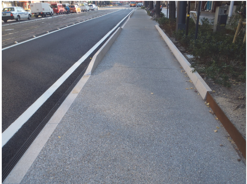
景観に配慮し、自転車道に暖かみを感じられる洗出しコンクリート舗装を採用(愛媛県松山市 花園町通り) 資料提供:松山市
