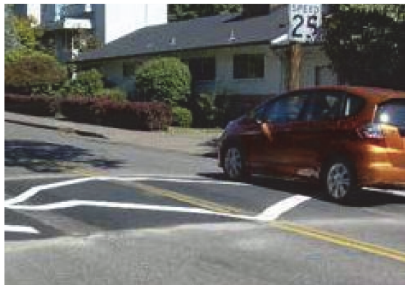
グリーンウェイを走行する自動車の速度を抑制するために、ハンプを設置 (アメリカ ポートランド市 ネイバーフッド・グリーンウェイ) 出典:Portland's NEIGHBORHOOD GREENWAYS ASSESSMENT REPORT
