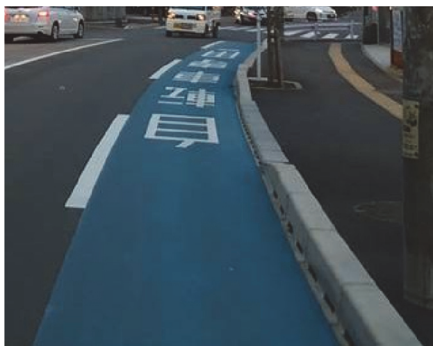
自転車専用通行帯における街渠例 出典：安全で快適な自転車利用環境創出ガイドライン
